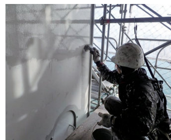
省工程塗料の塗装
