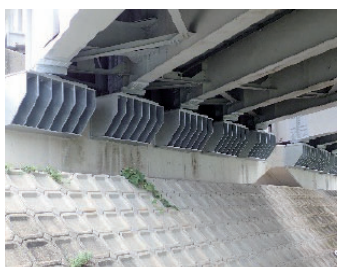
耐震補強工事 (水平力分担構造)
