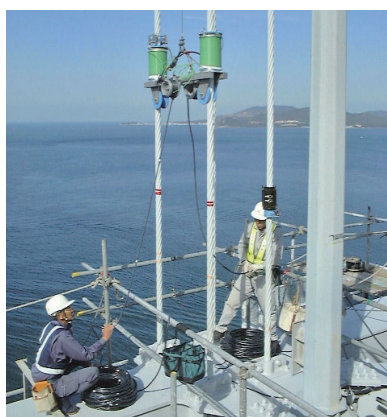
現地計測状況
