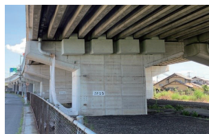
西田高架橋（岡山県倉敷市）
