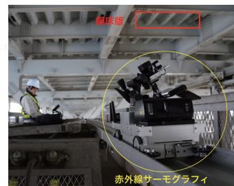
鋼床版の疲労亀裂点検
