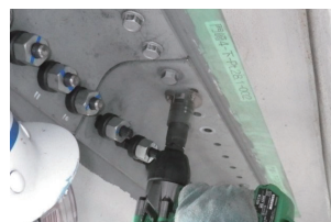
TRS*を用いた鋼床版疲労亀裂の補修 (関西大学との共同特許)
