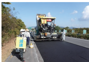
アスファルト舗装の補修
