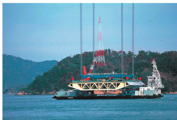
自航台船による直下吊架設工法（来島海峡大橋）
