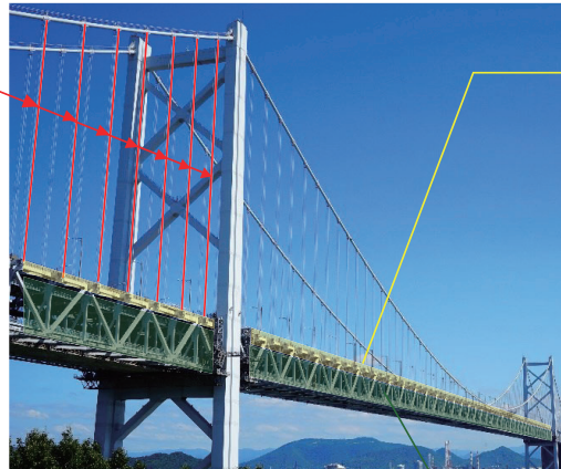
ハンガーロープ防食内部充填工法
