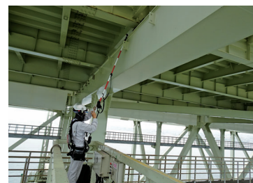
点検補修作業車による点検状況 (E28神戸淡路鳴門自動車道 明石海峡大橋)
