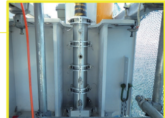
ハンガーロープ防食内部充填工法
