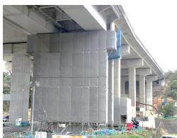
奥畑川橋（兵庫県洲本市）
