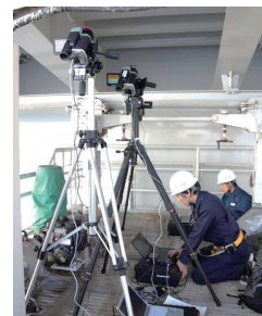
神戸大学との共同研究（鋼床版の疲労点検）
