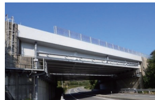
橋梁コンクリート表面保護対策
