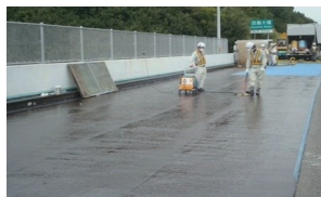
橋梁高性能床版防水
