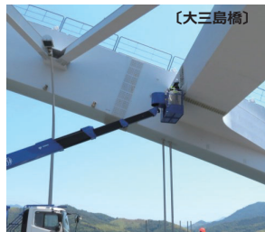
アーチ橋補修塗装
