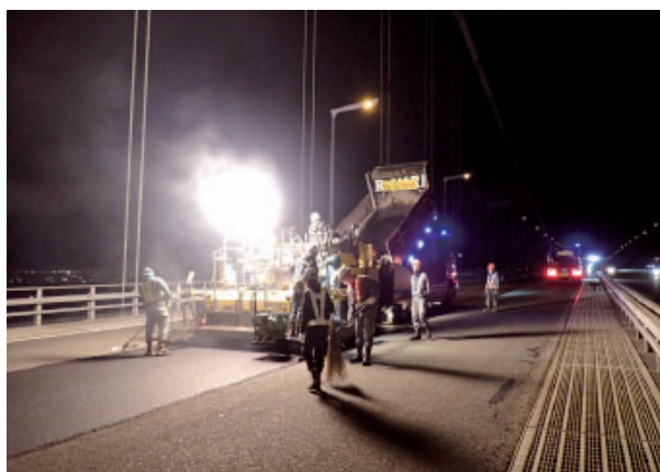
舗装補修工事状況 (E28 神戸淡路鳴門自動車道)
