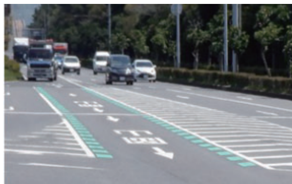
一般道誤進入対策（路面標示）
