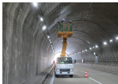
トンネル点検状況 (E30瀬戸中央自動車道 鷺野山トンネル)
