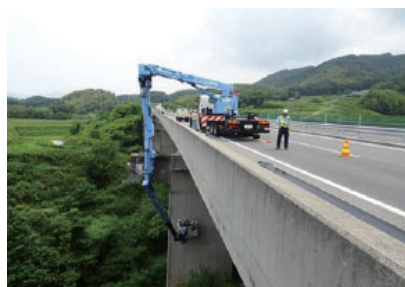
橋梁点検状況 (E28神戸淡路鳴門自動車道 中田川橋)
