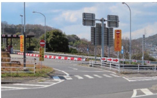
出口部誤進入対策（進入禁止板・矢印板）
