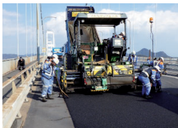
舗装補修工事状況 (E76 西瀬戸自動車道)
