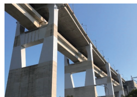
与島高架橋（香川県坂出市）
