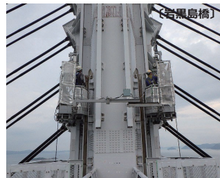
斜張橋塔塗替塗装
