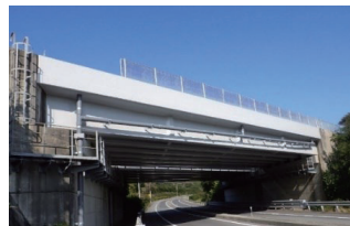
橋梁コンクリート表面保護対策
