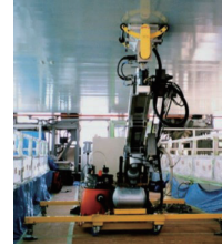
箱桁用塗装装置による塗装
