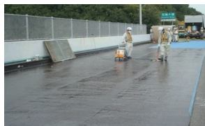
橋梁高性能床版防水
