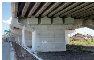
西田高架橋（岡山県倉敷市）
