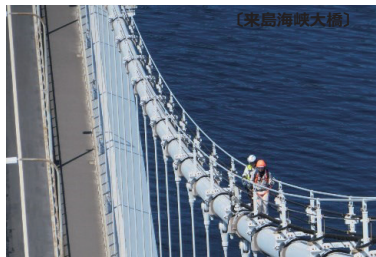
吊橋ケーブルの点検
