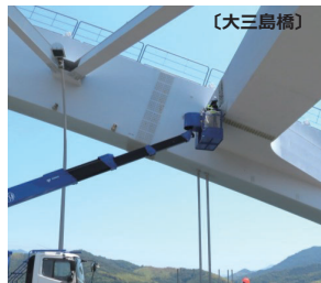
アーチ橋補修塗装
