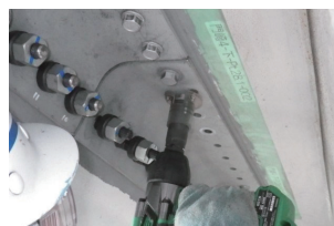
TRS*を用いた鋼床版疲労亀裂の補修 (関西大学との共同特許) ※TRS：スレッドローリングねじ (Thread Rolling Screw)
