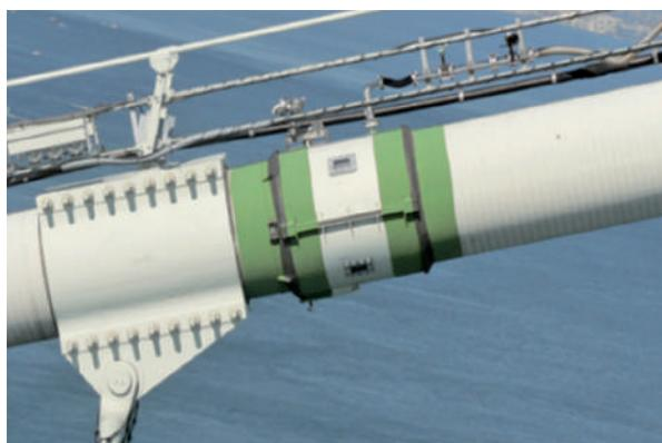
吊橋ケーブル送気乾燥システム
