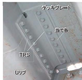
鋼床版の下面からの亀裂補修
