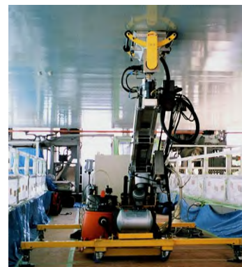
箱桁用塗装装置による塗装
