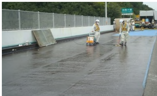
橋梁高性能床版防水
