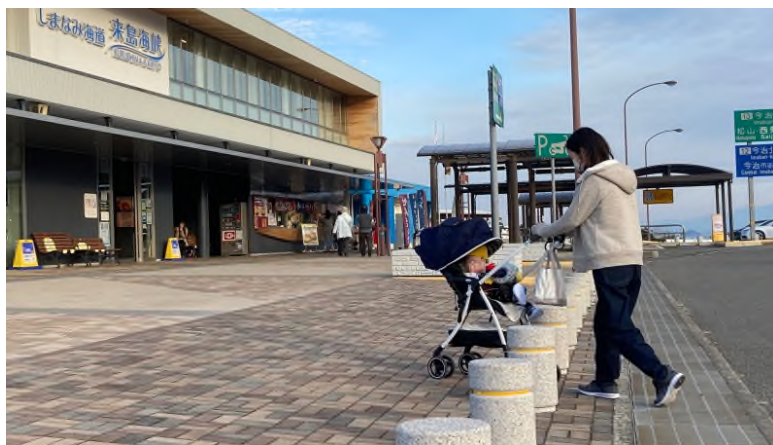
駐車場と通路間の段差の解消（来島海峡SA）
