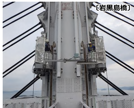
斜張橋塔塗替塗装
