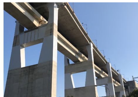
与島高架橋（香川県坂出市）
