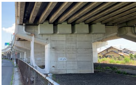
西田高架橋（岡山県倉敷市）
