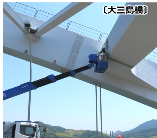
アーチ橋補修塗装
