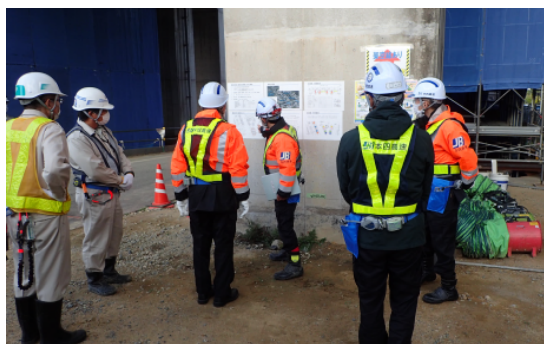
工事安全パトロール
