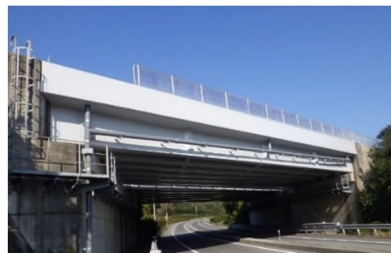
橋梁コンクリート表面保護対策
