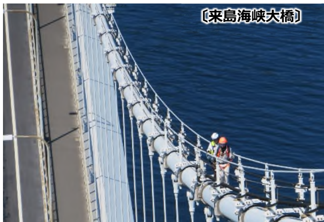
吊橋ケーブルの点検
