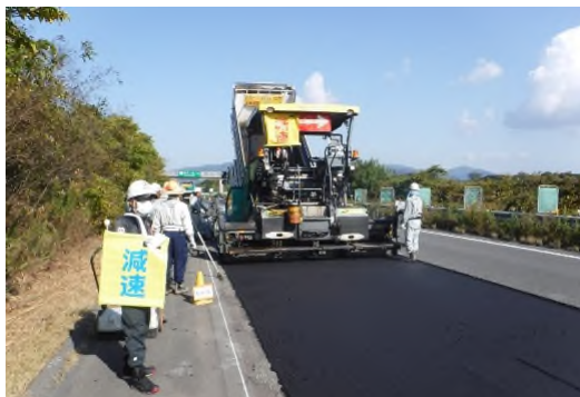
アスファルト舗装の補修
