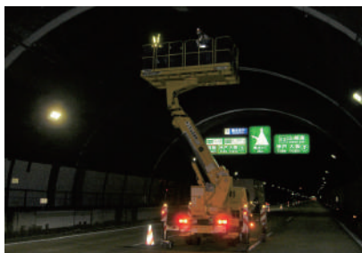
トンネル点検状況 (E28神戸淡路鳴門自動車道 舞子トンネル)
