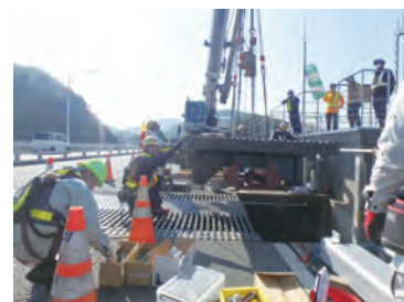
大型伸縮装置の補修 (E76西瀬戸自動車道 因島大橋)
