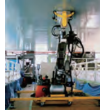
箱桁用塗装装置による塗装
