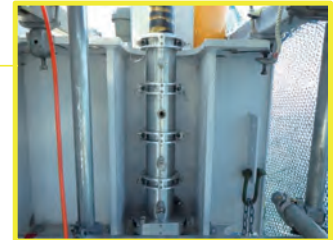
ハンガーロープ防食内部充填工法
