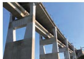
与島高架橋（香川県坂出市）
