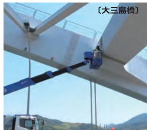
アーチ橋補修塗装
