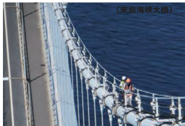
吊橋ケーブルの点検
