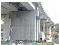
奥畑川橋（兵庫県洲本市）
