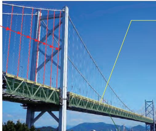
ハンガーロープ防食内部充填工法
