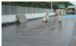
橋梁高性能床版防水
