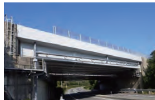
橋梁コンクリート表面保護対策
