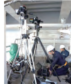
神戸大学との共同研究（鋼床版の疲労点検）
