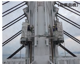
斜張橋塔塗替塗装
