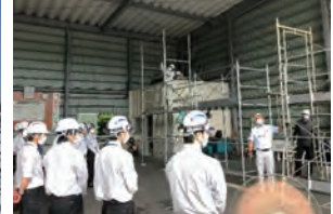
外部研修会（仮設足場）
