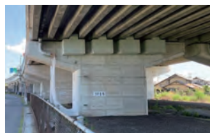
西田高架橋（岡山県倉敷市）
