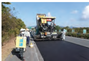
アスファルト舗装の補修
