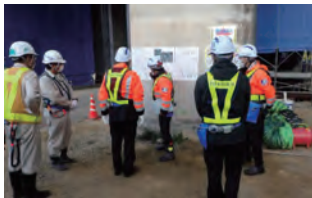
工事安全パトロール
