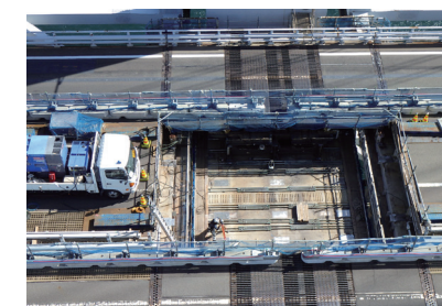
既設伸縮装置の撤去後状況
