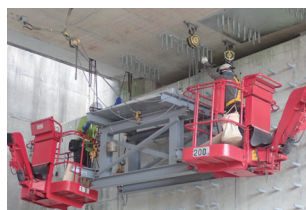
施工中(調整プレート設置)
