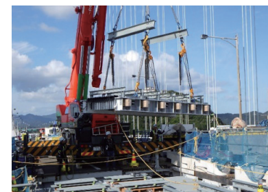
新規伸縮装置の設置状況
