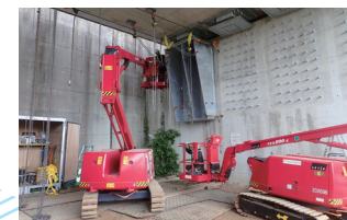
施工中(鋼製ブラケット設置)
