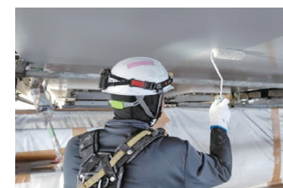
瀬戸大橋の塗替塗装状況
