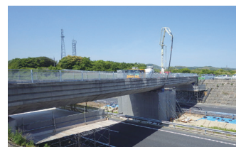
道路受託（跨道橋の耐震補強）
