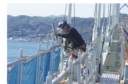
明石海峡大橋のハンガーロープ定着部補修（足場設置状況）
