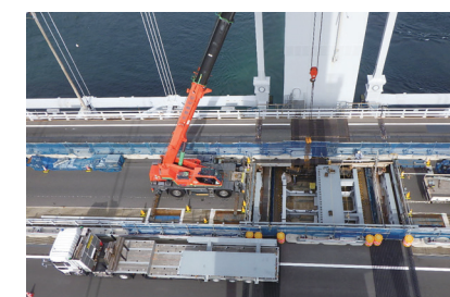
大鳴門橋大型伸縮装置の取替状況
