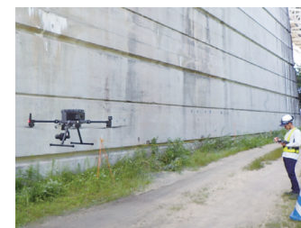
ドローンを活用した近接点検
