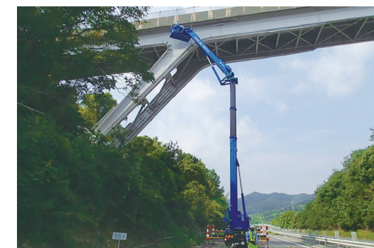
跨道橋の点検
