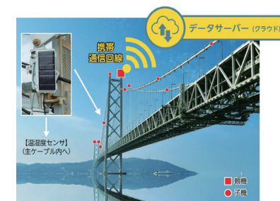
ケーブル送気監視システム（DRIoT）
