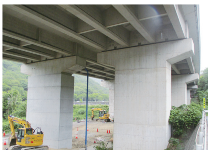
コンクリート巻立て工 [福江高架橋/岡山]
