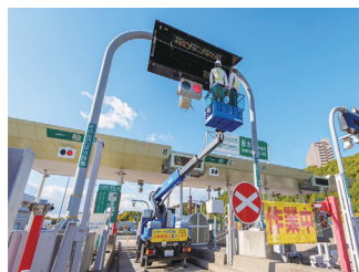
料金所設備のメンテナンス
