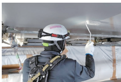
瀬戸大橋の塗替塗装状況
