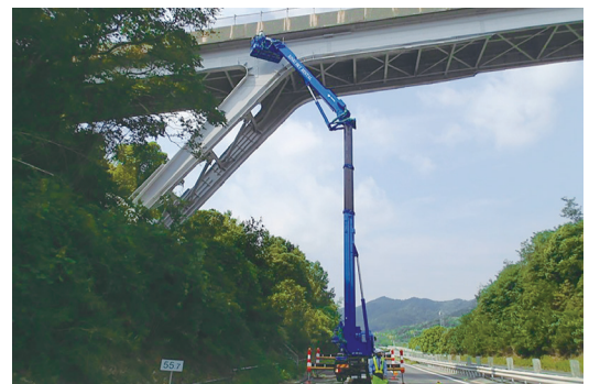
跨道橋の点検
