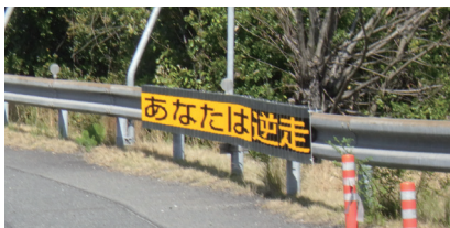
リバーシブル注意喚起板の設置
