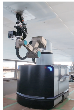
補修塗装ロボット
