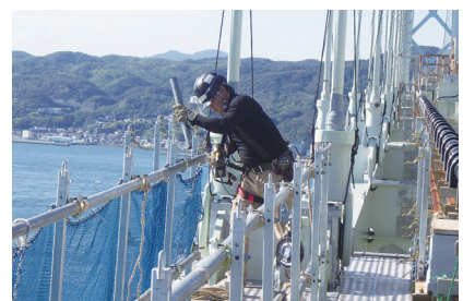
明石海峡大橋のハンガーロープ定着部補修 （足場設置状況）
