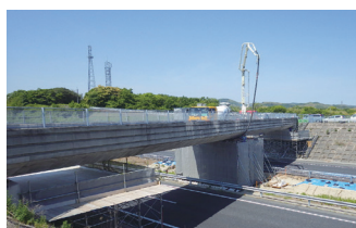
道路受託（跨道橋の耐震補強）
