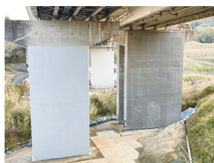
アラミド繊維巻立て工 [中田川橋/徳島]
