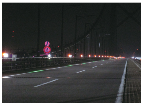
環境負荷と景観に配慮したLED低位置照明
