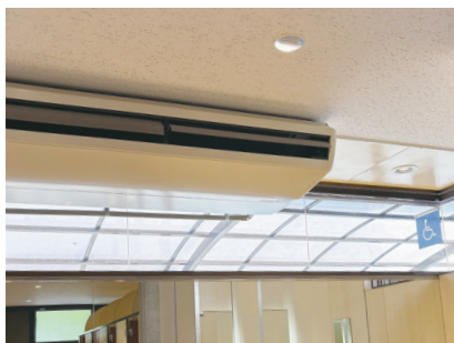
空調設備の設置（トイレ棟）
