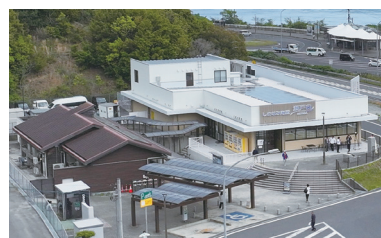
リニューアルした瀬戸田PA（上り）の休憩施設
