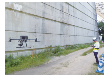
ドローンを活用した近接点検
