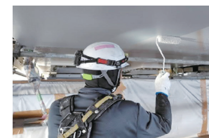
瀬戸大橋の塗替塗装状況
