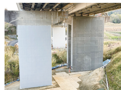
アラミド繊維巻立て工 [中田川橋/徳島]
