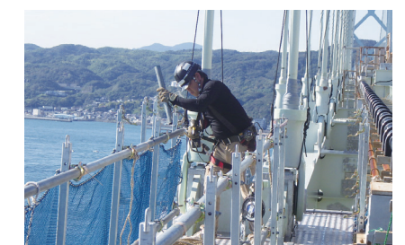
明石海峡大橋のハンガーロープ定着部補修（足場設置状況）
