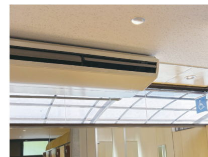
空調設備の設置（トイレ棟）
