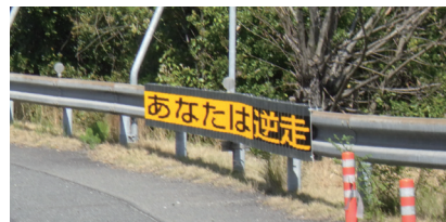
リバーシブル注意喚起板の設置
