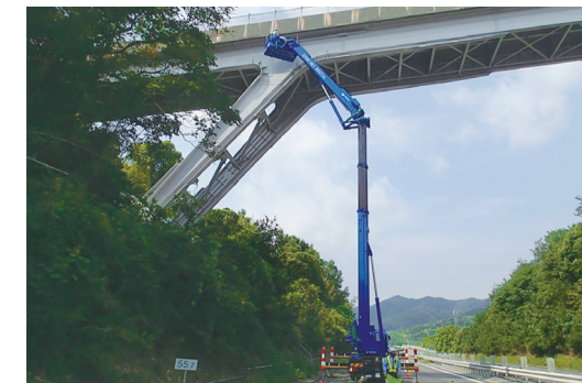
跨道橋の点検
