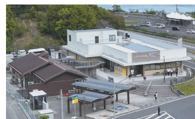
リニューアルした瀬戸田PA（上り）の休憩施設
