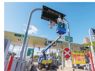
料金所設備のメンテナンス
