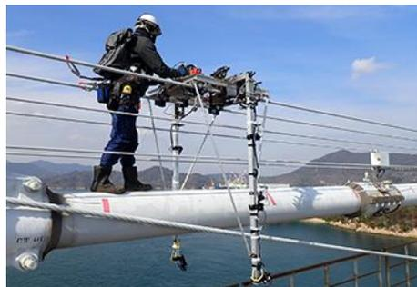
吊橋主ケーブル点検ロボット
