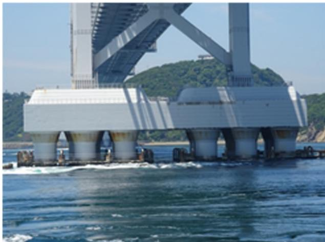
写真1 多柱基礎全景
