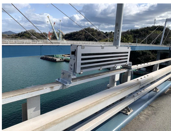
橋梁用広スパン低位置道路照明の設置状況(新尾道大橋)
