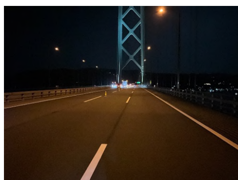
既設ポール照明の点灯イメージ
