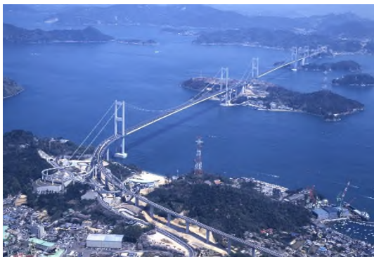
来島海峡大橋
