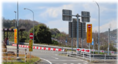
出口部誤進入対策 (進入禁止板・矢印板)
