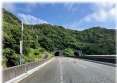
舗装補修 (施工前)
