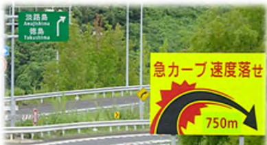
事故防止対策例 (注意喚起看板の設置)
