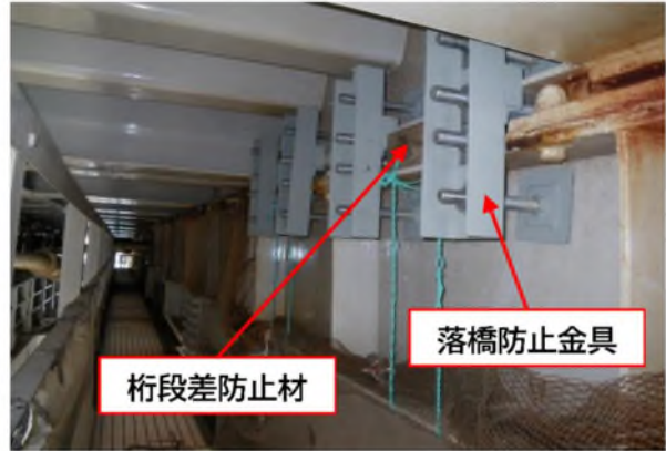
②落橋防止金具による応急措置状況
