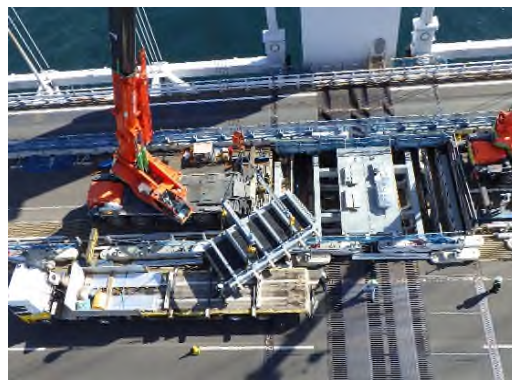
④（新）大型伸縮装置設置作業状況
