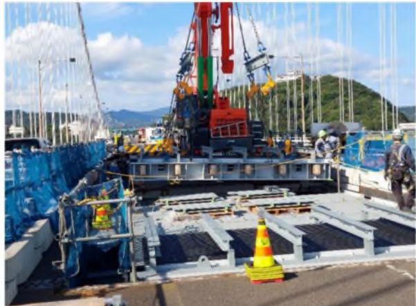
④(新)大型伸縮装置設置作業状況
