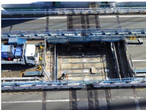
③(旧)大型伸縮装置撤去状況
