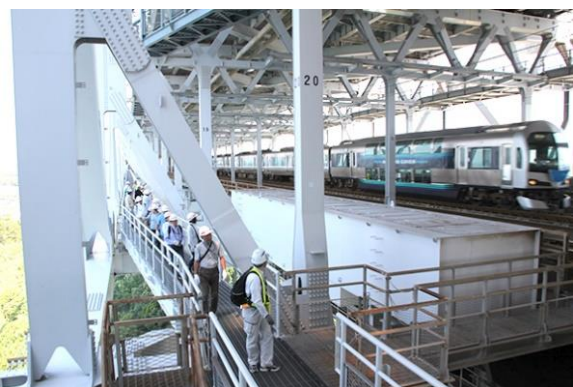
管理路よりJR瀬戸大橋線を望む
