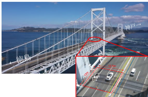
①大型伸縮装置交換箇所
