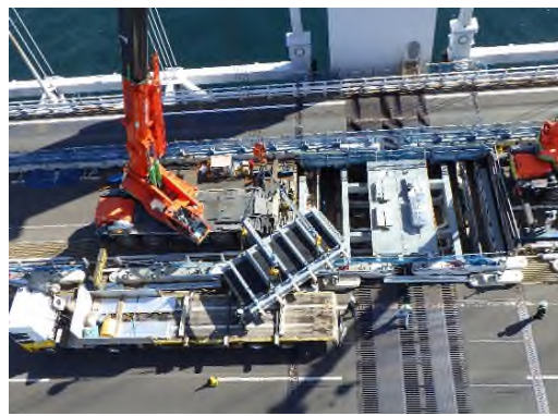
④（新）大型伸縮装置設置作業状況
