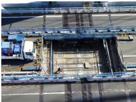
③(旧)大型伸縮装置撤去状況
