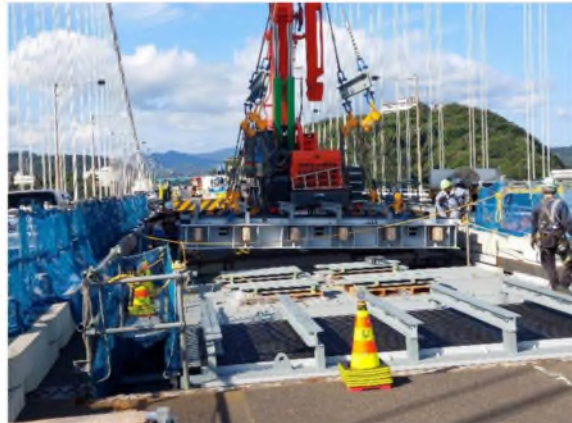
④(新)大型伸縮装置設置作業状況
