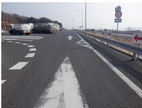
大型車駐車場リニューアル前
