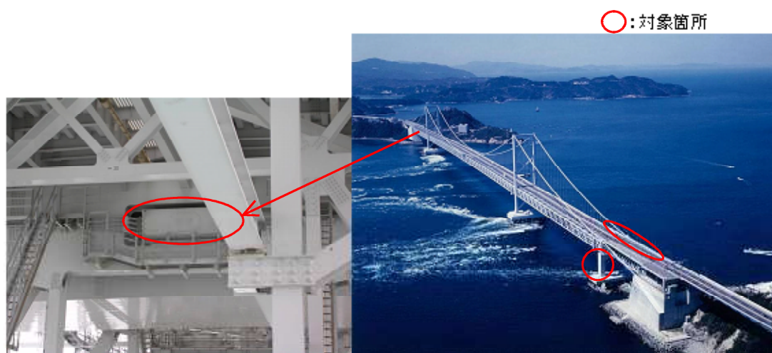
大鳴門橋の耐震補強
