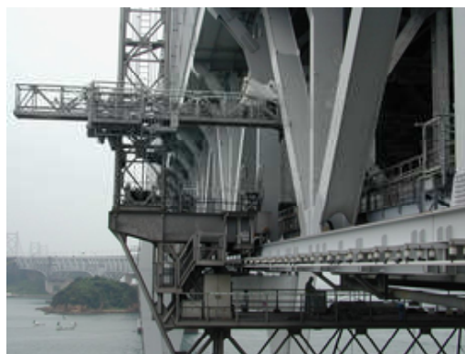
外面作業車を用いた塗り替え作業
