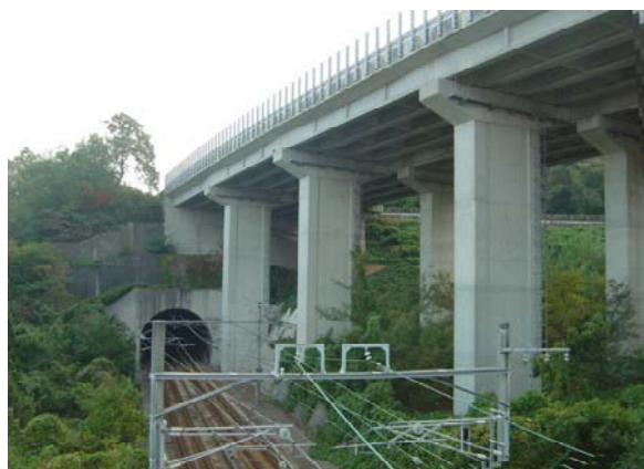
写真 JRを跨ぐ橋梁（大島高架橋）
