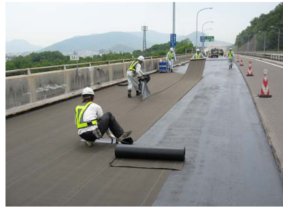
床版防水工による対策実施状況
