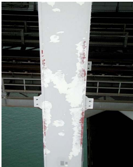
瀬戸大橋（櫃石島橋）主桁塗膜損耗状況 枠組み足場による補剛桁塗装状況
