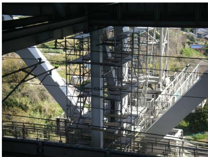
瀬戸大橋（櫃石島橋）主桁塗膜損耗状況 枠組み足場による補剛桁塗装状況
