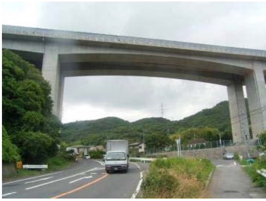
県道を跨ぐ橋梁
