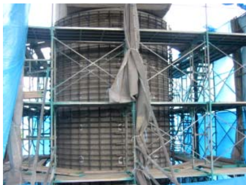
(鉄筋組み立て)
