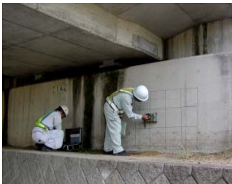
コンクリート非破壊検査状況
