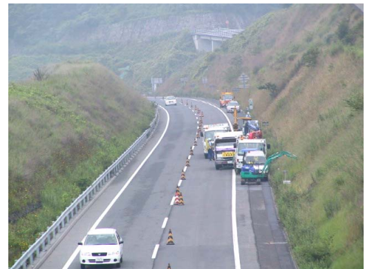
道路維持作業での車線規制状況
