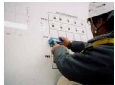
塗膜調査状況
