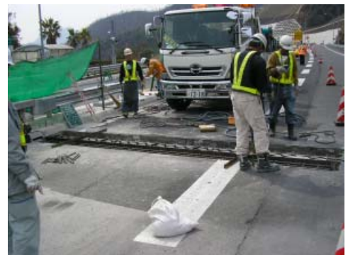
橋梁補修（伸縮装置）工事状況
