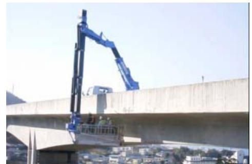
橋梁点検車を用いた橋梁点検状況
