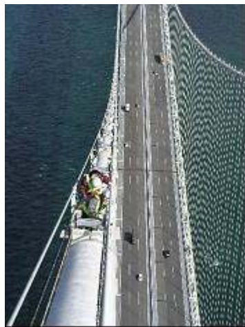
長大橋吊橋主ケーブル点検
