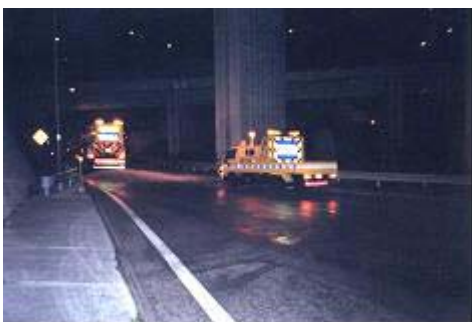
凍結防止剤散布作業
