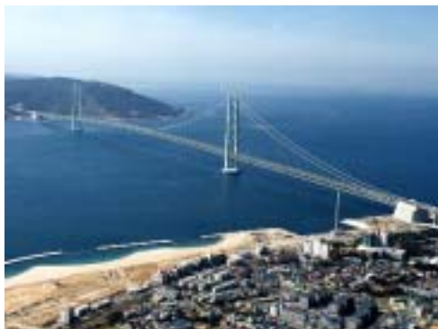
明石海峡大橋
