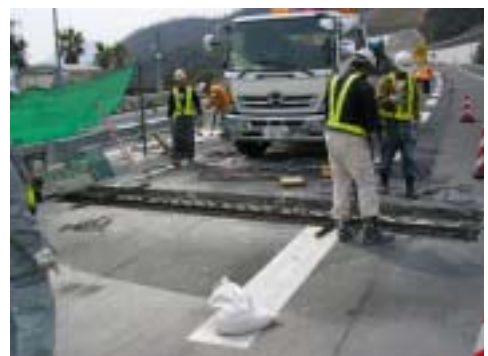
橋梁補修（伸縮装置）工事状況
