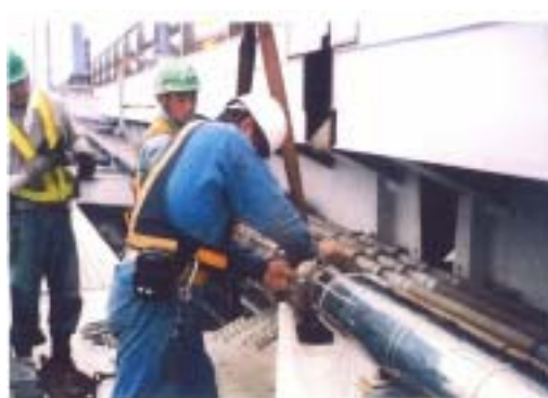
《給水管点検整備状況》 （一般国道30号 番の州高架橋）
