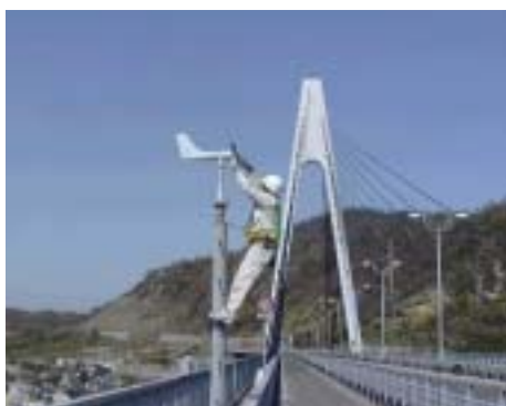
《風速計点検状況》 （一般国道317号 生口橋）
