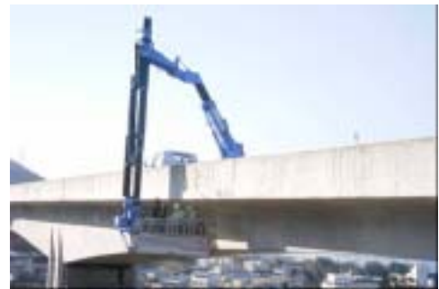
橋梁点検車を用いた橋梁点検状況
