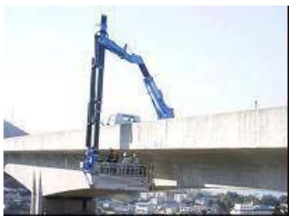
橋梁点検車を用いた橋梁点検
