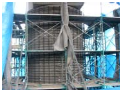
(鉄筋組み立て)
