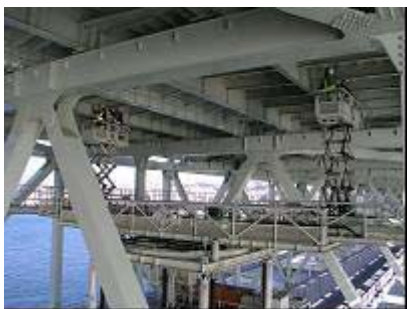
桁内面作業車を用いた長大橋点検
