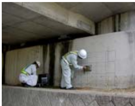
コンクリート非破壊検査状況
