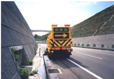
路面清掃作業
