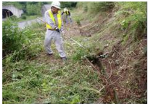
排水溝清掃作業
