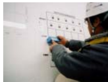
塗膜調査状況
