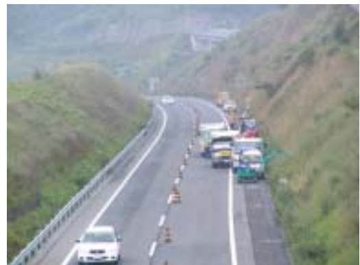
道路維持作業での車線規制状況
