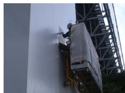
ゴンドラによる主塔の塗替塗装状況
