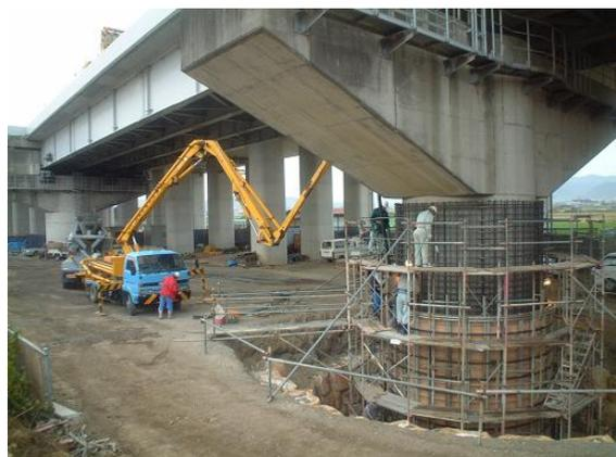
鉄筋コンクリート巻立て工法による耐震補強
