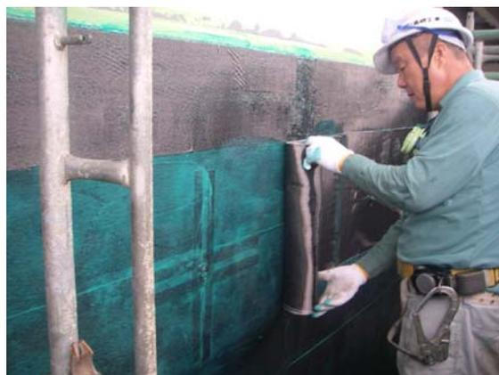
炭素繊維巻立て工法による耐震補強
