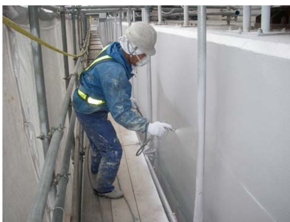
足場による表面被覆塗装状況 (一般国道 30 号 南北備讃瀬戸大橋)
