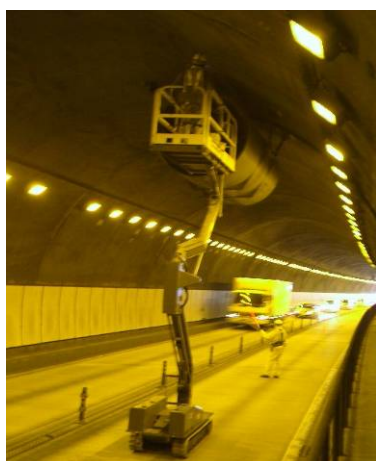
リフト車を用いたジェットファン点検状況 (一般国道 317 号 宮窪トンネル)
