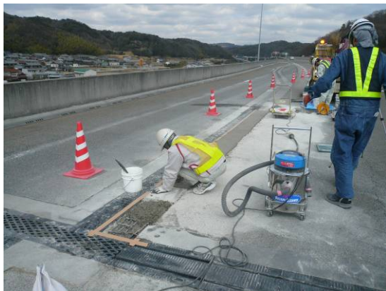
伸縮装置補修状況 (一般国道 28 号 布施畑高架橋)
