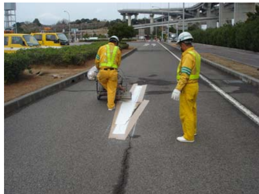
路面表示工施工状況 (一般国道30号 与島PA)
