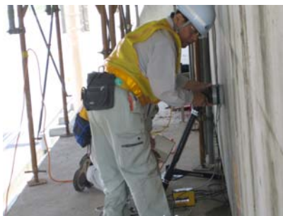
コンクリートの非破壊検査状況 （一般国道 28 号 淡路 IC ランプ橋）
