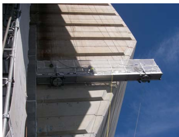
ゴンドラによる表面被覆塗装状況 (一般国道 30 号 南北備讃瀬戸大橋)
