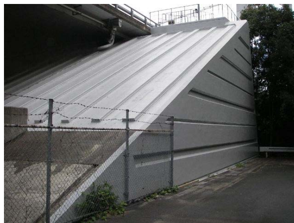
吊橋アンカレイジ表面被覆状況 (一般国道 317 号 大島大橋)
