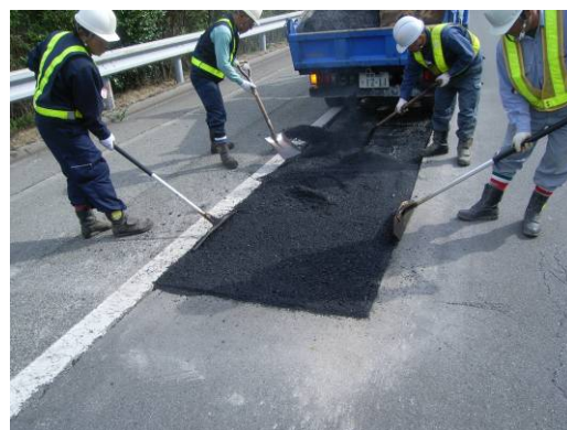
ポットホール補修状況 (一般国道30号 水島IC～児島IC)
