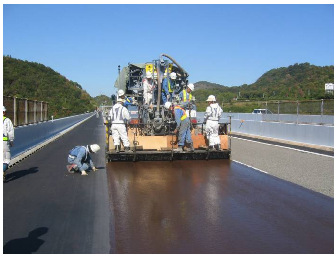
マイクロサーフェシング工法による舗装補修工事状況 (一般国道 30 号 塩生橋)
