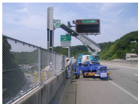
橋梁点検車を用いた標識点検状況 (一般国道 28 号 神戸西 IC～布施畑 IC)
