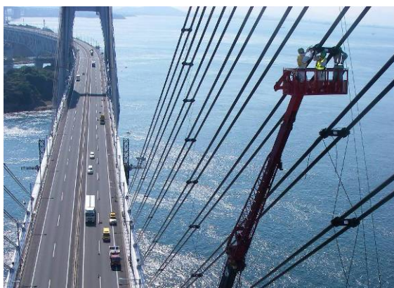
斜張橋ケーブル制振ワイヤー補修状況 (一般国道 30 号 岩黒島橋)
