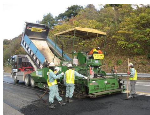
舗装補修工事状況 (一般国道317号 伯方島IC～大島北IC)
