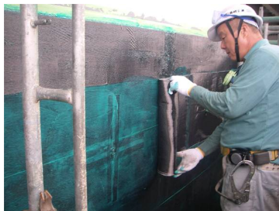
炭素繊維巻立て工法による耐震補強 (一般国道 28 号 大鳴門橋)
