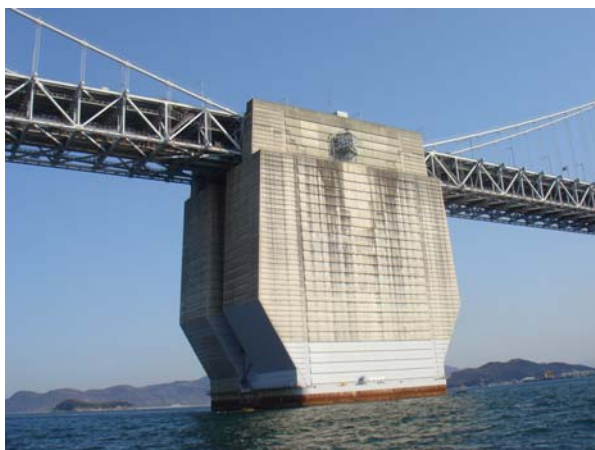
吊橋アンカレイジの表面被覆状況 (一般国道 30 号 南北備讃瀬戸大橋)
