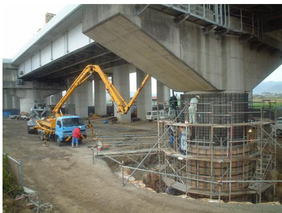
鉄筋コンクリート巻立て工法による耐震補強 (一般国道 28 号 志知高架橋)
