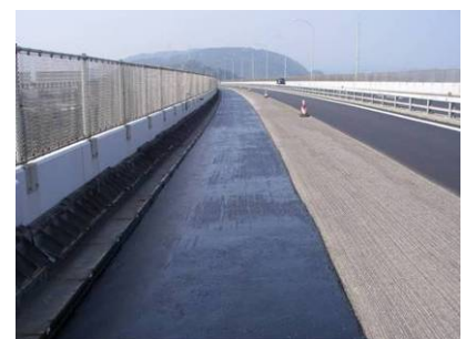
床版防水工の施工状況（予防保全） （一般国道 28 号 亀浦高架橋）
