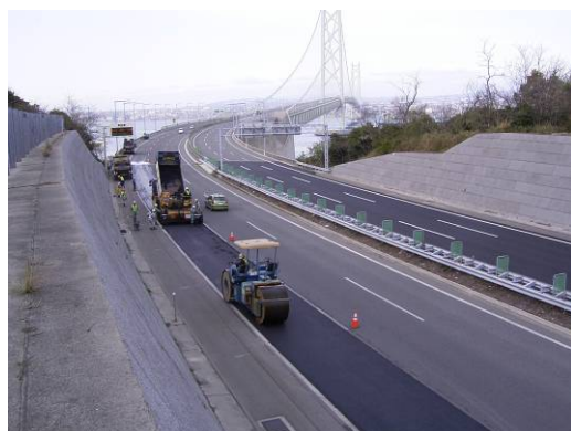
舗装補修状況 (一般国道28号 垂水IC～淡路IC間)
