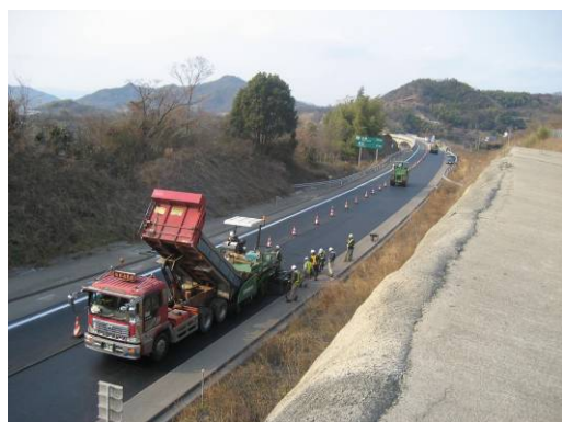
舗装補修状況 (一般国道317号 因島北IC～因島南IC間)
