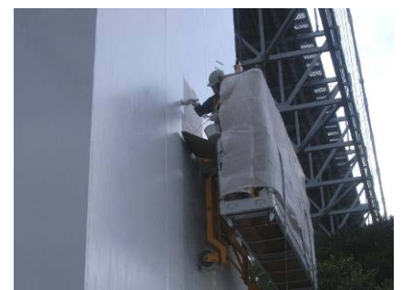
ゴンドラによる主塔の塗替塗装状況 (一般国道 317 号 因島大橋)
