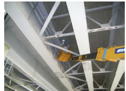
リフト車を用いた橋梁点検状況 （一般国道 28 号 山田原橋）
