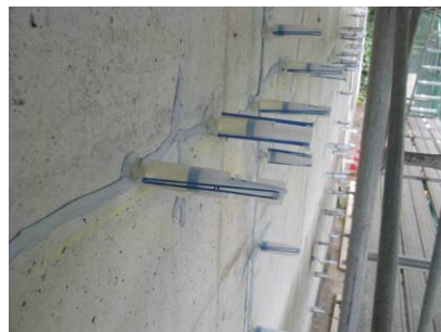
橋台のひび割れ補修状況（予防保全） （一般国道 317 号 永江川橋）
