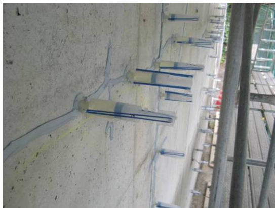
橋台のひび割れ補修状況 (一般国道 317 号 永江川橋)
