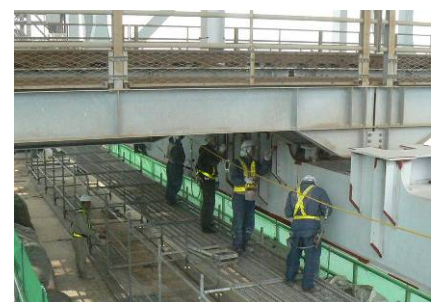
補剛桁の塗替塗装状況 (一般国道30号 瀬戸大橋)
