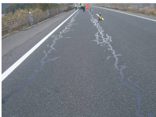
舗装補修前の路面状態 (一般国道28号 津名一宮IC～洲本IC)
