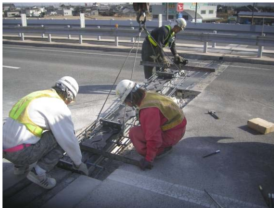
伸縮装置補修状況 (一般国道 30 号 亀山高架橋)
