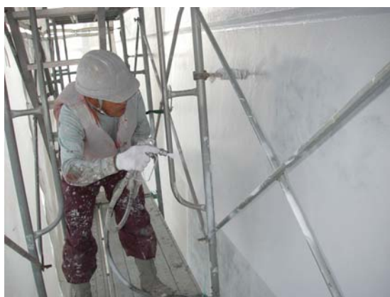
吊橋アンカレイジ表面被覆塗装実施状況 (一般国道 30 号 南北備讃瀬戸大橋)
