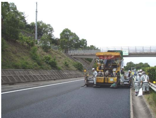
舗装補修状況 (一般国道30号 水島IC~児島IC間)
