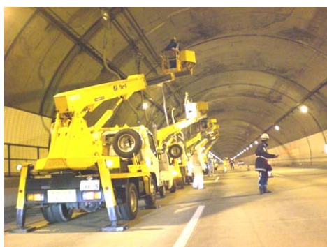
トンネル防災設備の点検状況 (一般国道 28 号 舞子トンネル)
