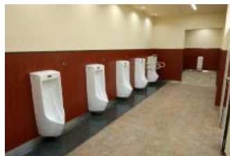
トイレ施設の改修(与島PA)
