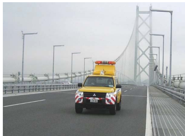
道路巡回業務 (一般国道28号 淡路IC~垂水IC)
