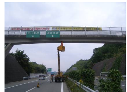
リフト車を用いた橋梁点検状況 （一般国道28号 高山跨道橋）
