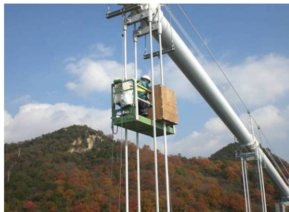
ハンガーロープ補修状況 (一般国道 317 号 因島大橋)
