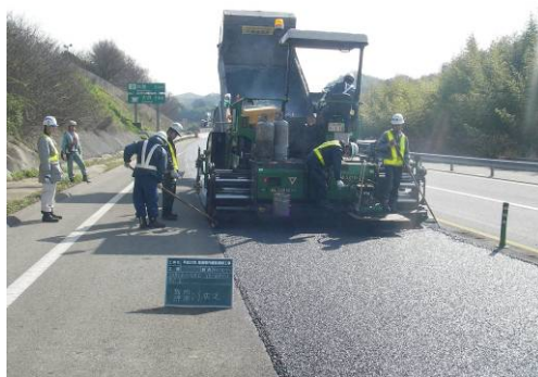
舗装補修工事状況 (一般国道317号 西瀬戸尾道IC～向島IC)
