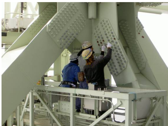
吊橋補剛桁の補修塗装状況 (一般国道 28 号 明石海峡大橋)
