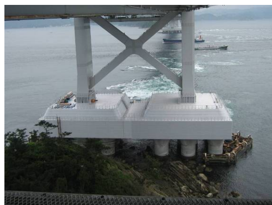
吊橋主塔基礎コンクリート塗装実施状況 (一般国道 28 号 大鳴門橋)
