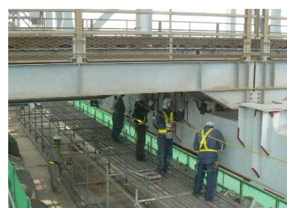
補剛桁の塗替塗装状況 (一般国道30号 瀬戸大橋)
