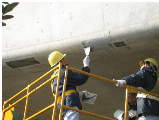
主桁の断面修復状況 (一般国道 28 号 木津高架橋)
