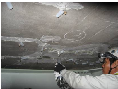
床版のひび割れ補修状況（予防保全） （一般国道28号 淡路SA Oランプ橋）
