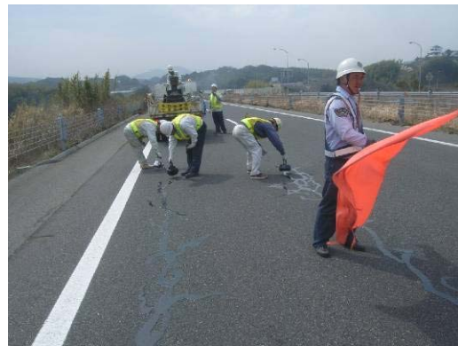
ひびわれ補修状況 (一般国道28号 津名一宮IC~洲本IC)
