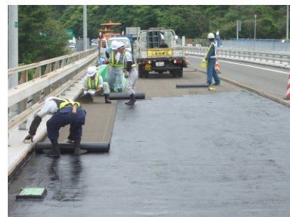
床版防水工の施工状況（予防保全） （一般国道317号 大三島橋）
