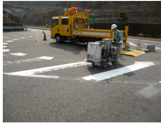
路面標示工補修状況 (一般国道30号 粒江PA下り)
