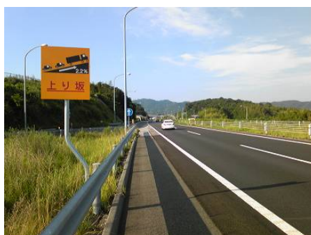
標識設置状況 (一般国道 28 号 津名一宮 IC 付近)
