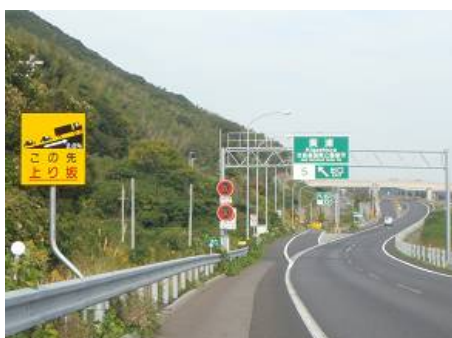
標識設置状況 (一般国道 28 号 東浦 IC 付近)
