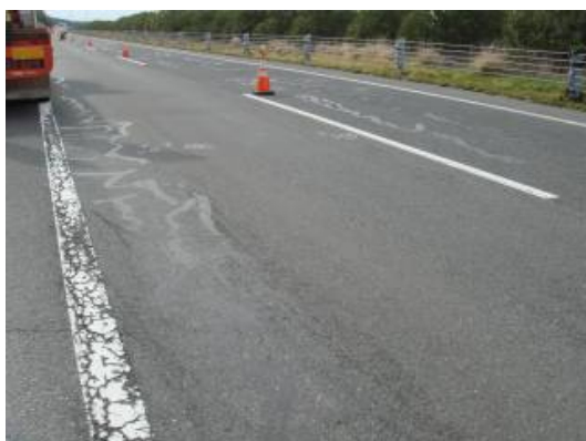
舗装補修前の路面状態 (一般国道28号 北淡IC～東浦IC)
