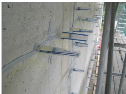
ひび割れ補修状況(予防保全) (一般国道317号 永江川橋)
