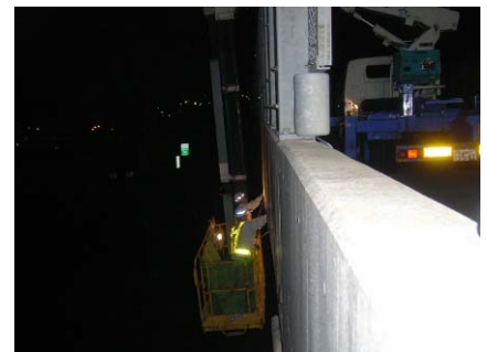
橋梁点検車を用いた橋梁点検状況 (一般国道317号 高部高架橋)
