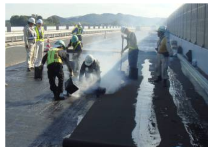
床版防水工の施工状況(予防保全) (一般国道30号 粒江高架橋)
