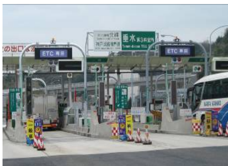
ETCレーン増設状況 (一般国道 28 号 垂水IC)
