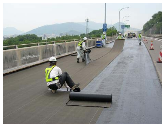
床版防水工の施工状況
