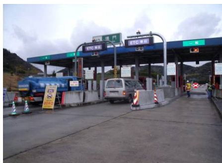
ETCレーン増設状況 (一般国道 28 号 鳴門IC)
