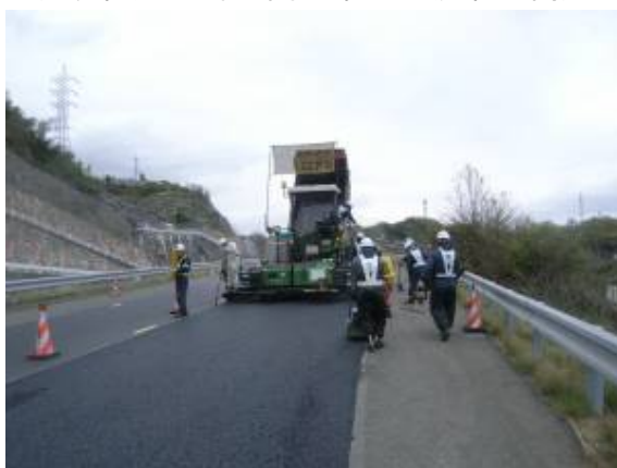
舗装補修状況 (一般国道317号 西瀬戸尾道IC～向島IC間)
