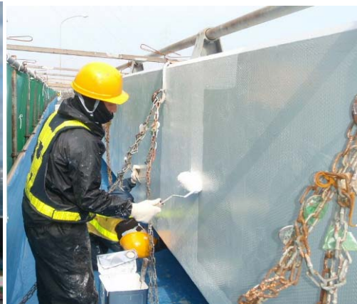
壁高欄補修状況 （一般国道 30 号 番の州南高架橋）
