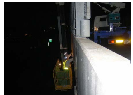
橋梁点検車を用いた橋梁点検状況 （一般国道 317 号 高部高架橋）
