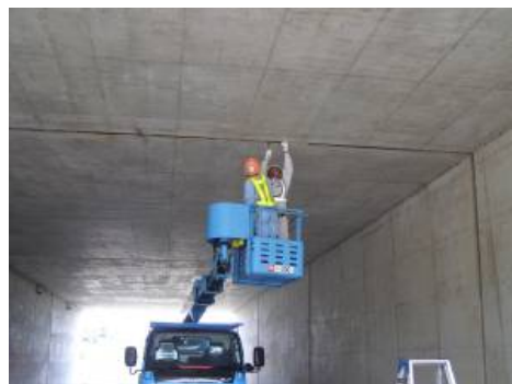
カルバートボックス目地点検状況 (一般国道 28 号 東浦 IC 付近)
