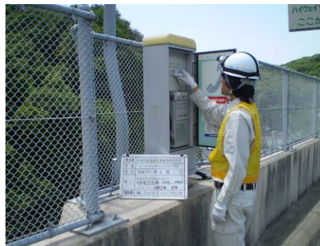
非常電話の点検状況 (一般国道 28 号 神戸西 IC～布施畑 IC)
