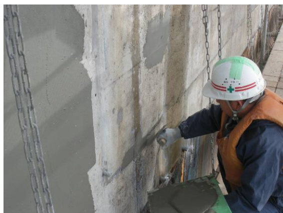
吊橋アンカレイジのコンクリート表面修復状況 (一般国道 30 号 南北備讃瀬戸大橋)
