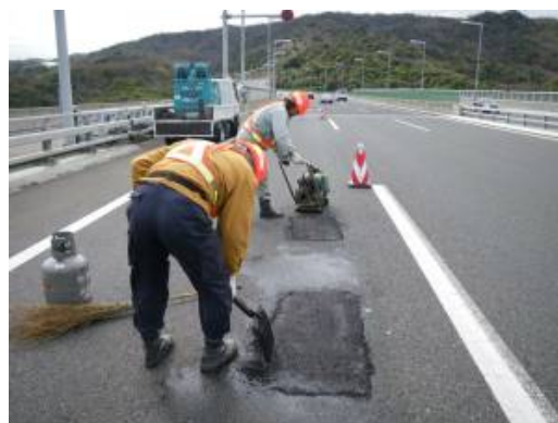
ひびわれ補修状況 (一般国道28号 垂水IC～淡路IC)
