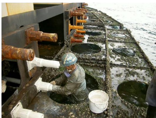
船舶緩衝工取付けボルトの補修塗装状況 （一般国道 28 号 明石海峡大橋）
