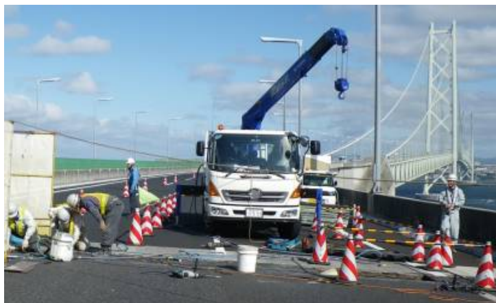
伸縮装置補修状況 （一般国道 28 号 松帆高架橋）
