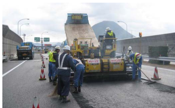
舗装補修工事状況 (一般国道 30 号 坂出北IC～坂出IC)
