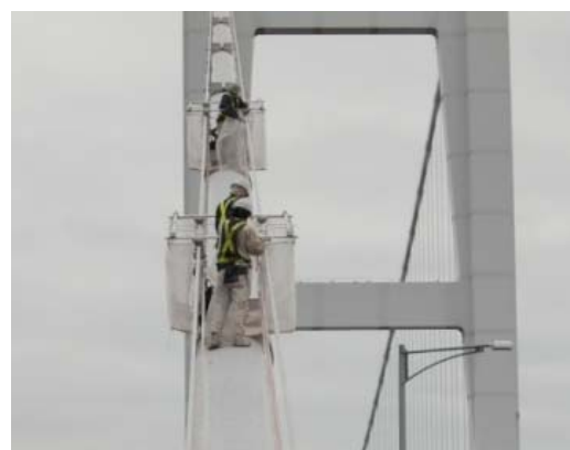
ハンドロップ支柱の補修状況 （一般国道 30 号 下津井瀬戸大橋）
