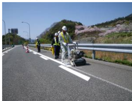
路面標示工補修状況 (一般国道317号 生口島南IC Bランプ)
