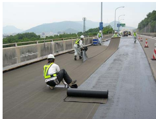
床版防水工の施工状況
