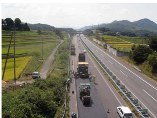
舗装補修状況 (一般国道28号 津名一宮IC～洲本IC間)
