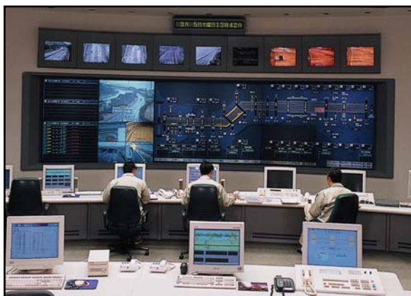
交通管制業務 (神戸管理センター管制室)
