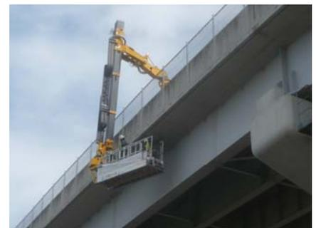
橋梁点検車を用いた橋梁点検状況
