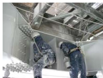
補剛桁の塗替塗装状況
