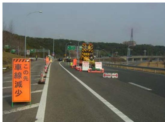
車線規制状況(舗装補修時)
