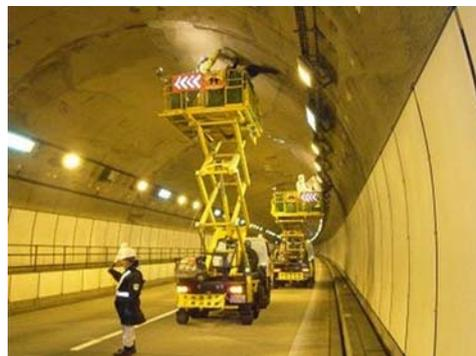
トンネル覆工版打音点検状況
