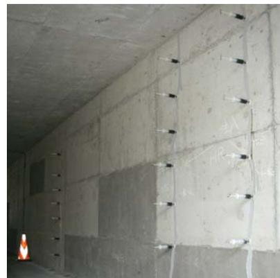
カルバートボックスひびわれ補修状況
