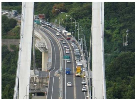
片側交互規制状況(舗装補修時)
