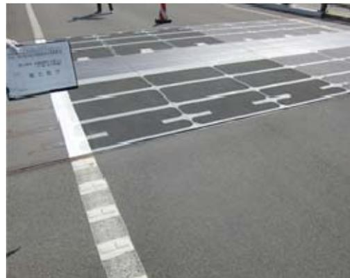
大型伸縮装置の補修塗装状況
