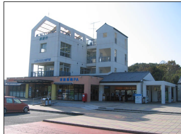
淡路島南PA(上り)休憩施設
