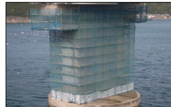
橋梁耐震補強(撫養橋)
