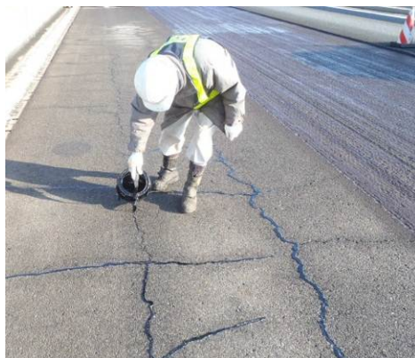
ひび割れ補修状況 (一般国道30号 水島IC~児島IC間)
