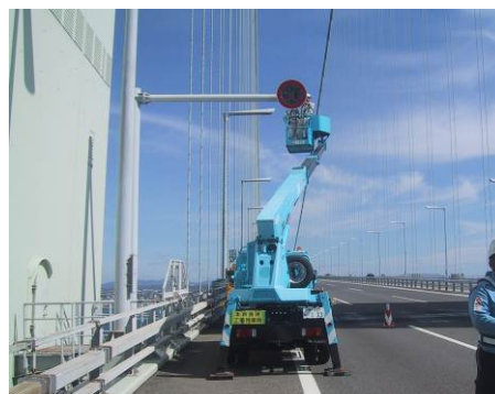
可変速度標識の点検状況 (一般国道 28 号 明石海峡大橋)
