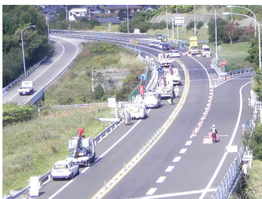
片側交互規制状況(防護柵設置時) (一般国道317号 叶浦高架橋)
