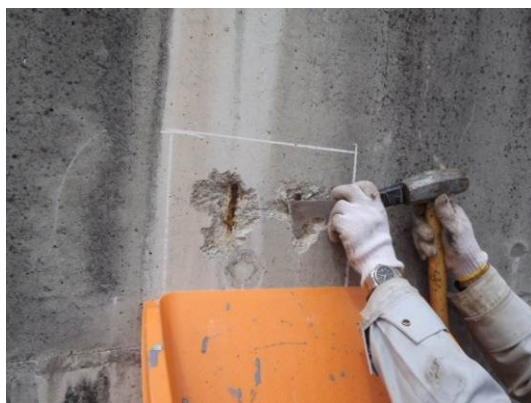
断面修復状況 (一般国道 28 号 垂水 JCT ランプ橋)
