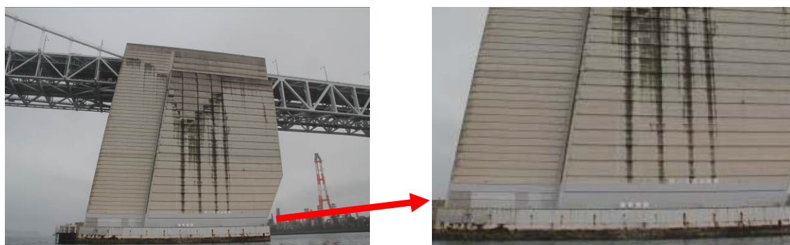
吊橋アンカレイジの防食塗装状況 (一般国道30号 南備讃瀬戸大橋)
