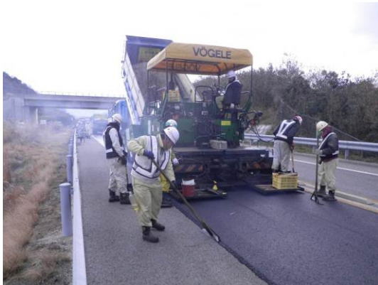
舗装補修状況 (一般国道317号 今治北IC~今治IC間)
