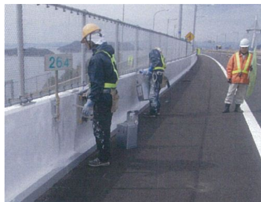
壁高欄補修状況 (一般国道 30 号 与島高架橋)
