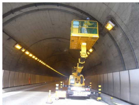
トンネル覆工版打音点検状況 (一般国道 30 号 柳田トンネル)
