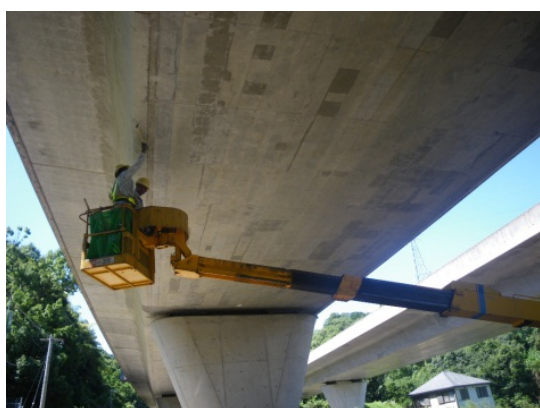
橋梁点検状況 （一般国道28号 撫養高架橋）
