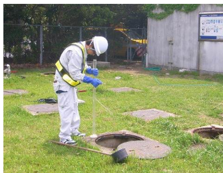
汚水処理設備の点検状況 (一般国道 28 号 淡路島南 PA)
