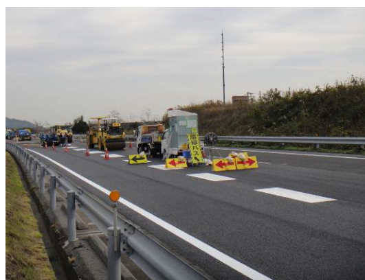
車線規制状況(舗装補修時) (一般国道28号 東浦IC~北淡IC)
