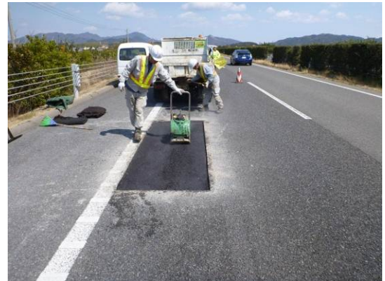
ポットホール補修状況 (一般国道28号 津名一宮IC~西淡三原IC間)
