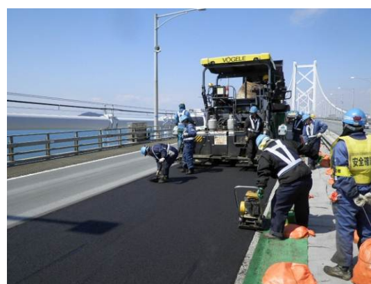
舗装補修工事状況 （一般国道30号 南備讃瀬戸大橋）
