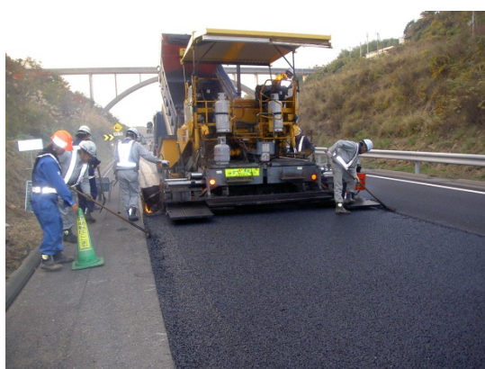
舗装補修工事状況 （一般国道28号 東浦IC～北淡IC）
