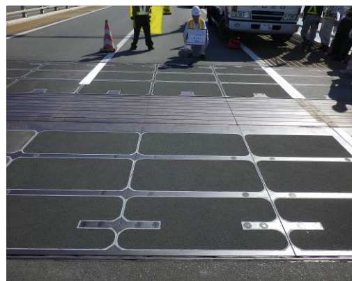
大型伸縮装置の補修塗装状況 (一般国道 30 号 南備讃瀬戸大橋)
