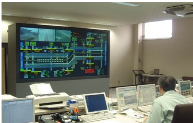
【管制室】 (岡山管理センター管制室)
