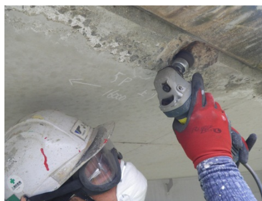
橋梁補修(断面修復)状況 （一般国道317号 江尻川橋）
