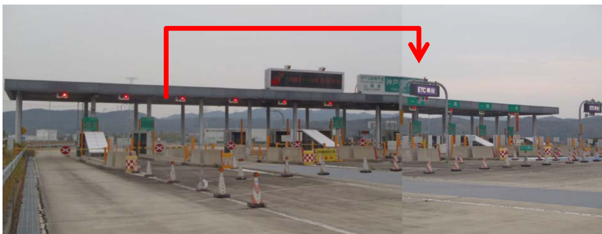
ETCレーン移設状況 (一般国道 28 号 神戸西 IC)
