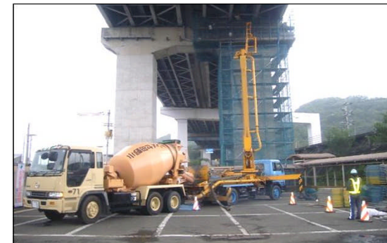
橋梁耐震補強(撫養橋南高架橋)
