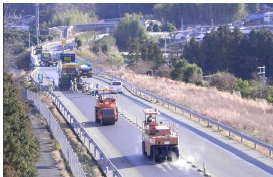
舗装補修(西瀬戸自動車道)
