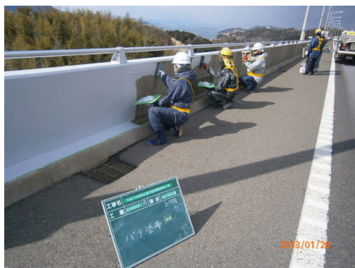
壁高欄の塗装
