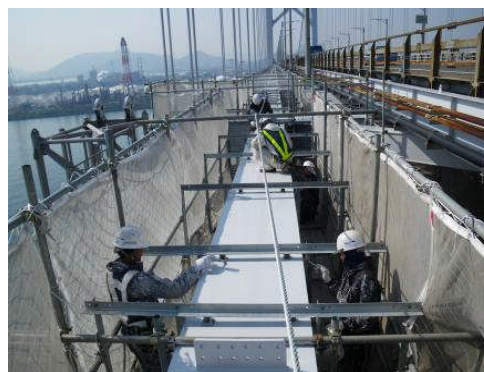
補剛桁の塗替塗装状況 (一般国道 30 号 瀬戸大橋)
