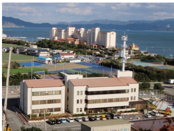
鳴門管理センター外観
