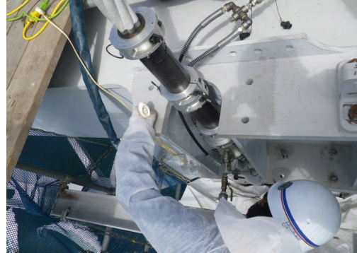
吊橋ハンガーロープ定着部の補修状況 (一般国道 28 号 大鳴門橋)
