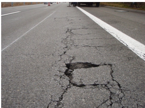
舗装の損傷および補修の状況
