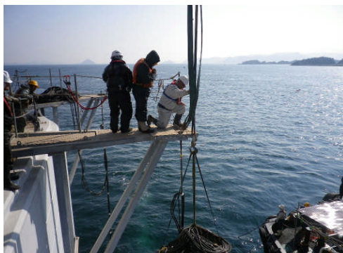
電着設備（陽極支持ロープ）設置状況 (一般国道 30 号 岩黒島橋 3 P)
