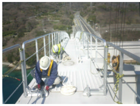
アーチリブ上管理用手摺の補修 (一般国道 317 号 大三島橋)
