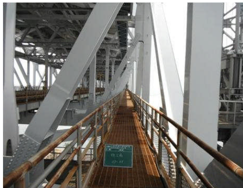
管理路補修塗装・再メッキ完了 (一般国道 30 号 北備讃瀬戸大橋)
