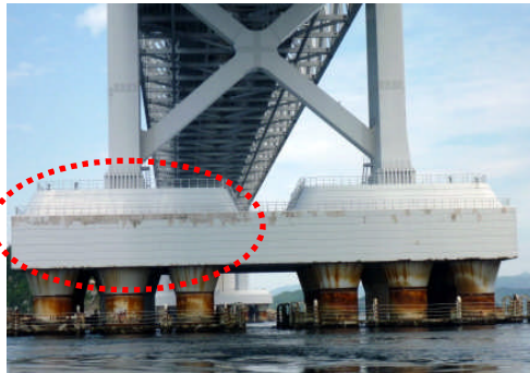
吊橋橋脚基礎の表面被覆状況 (一般国道 28 号 大鳴門橋)
