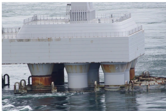
3P 飛沫部・干満部(一部)完了 (一般国道 28 号 大鳴門橋)
