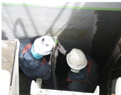
ドライボックス内でのブラスト作業 (同左)
