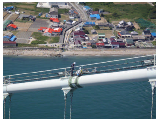
主ケーブル上での点検 （一般国道28号 明石海峡大橋）
