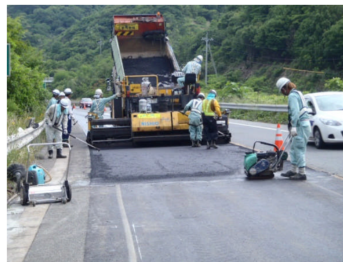
舗装の損傷および補修の状況
