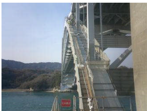
管理路補修塗装・再メッキ完了 (一般国道 30 号 北備讃瀬戸大橋)
