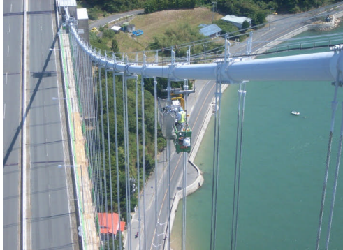
吊橋ハンガーロープ一般部の補修状況 (一般国道 317 号 因島大橋)
