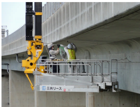
橋梁定期点検
