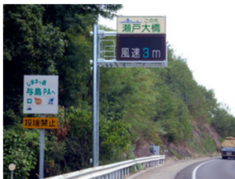
新・風速表示板(一般国道 30 号)設置
