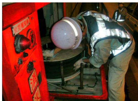
トンネル消火栓点検
