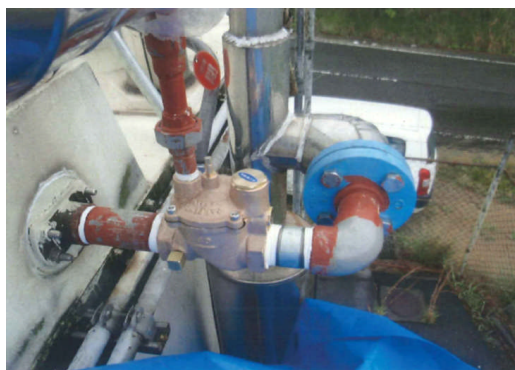
S A 給水設備 受水槽定水位弁交換
