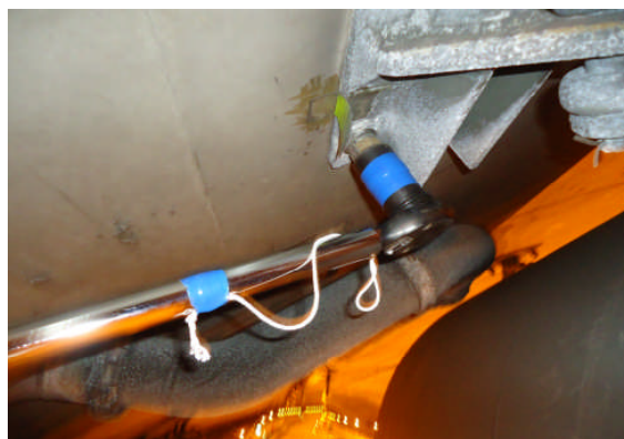
上りジェットファン再締付状況
