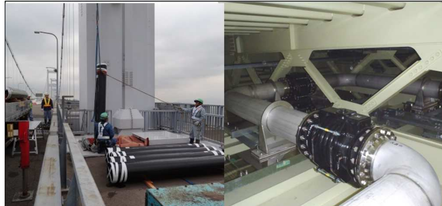
来島海峡大橋送水管添架工事
