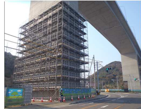
剥落防止対策(亀浦高架橋)
