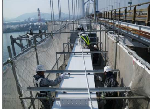
長大橋塗替塗装(瀬戸大橋)
