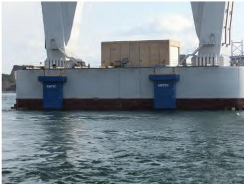
海中基礎の補修塗装(ドライボックス設置)
