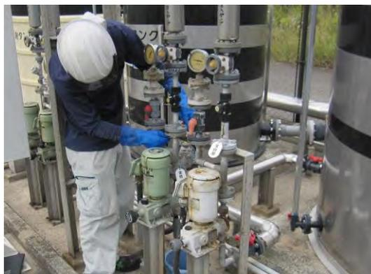
S A 汚水処理設備 配管補修弁交換
