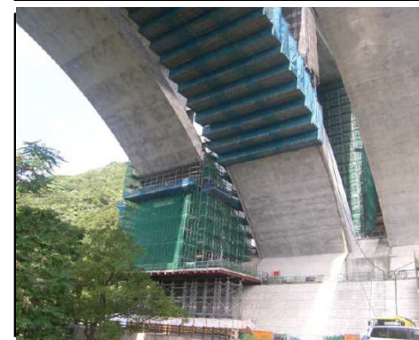
耐震補強(茶間川橋)
