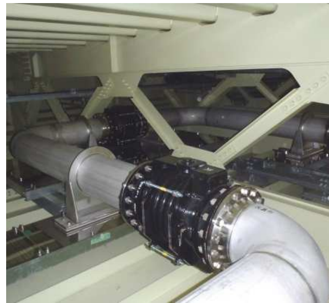
来島海峡大橋送水管添架工事
