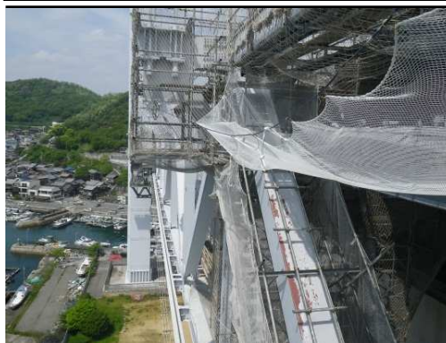
長大橋塗替塗装(瀬戸大橋)
