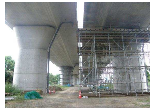
耐震補強(撫養高架橋)
