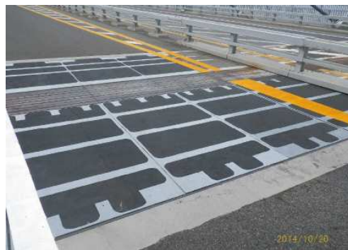
伸縮装置表面処理完了 (一般国道 317 号 多々羅大橋)
