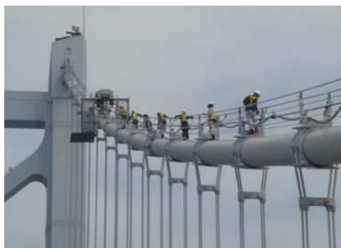
送気カバー増設(送気管)施工状況 (一般国道 30 号 瀬戸大橋)
