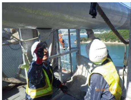
塗替塗装状況 (一般国道 317 号 大島大橋)
