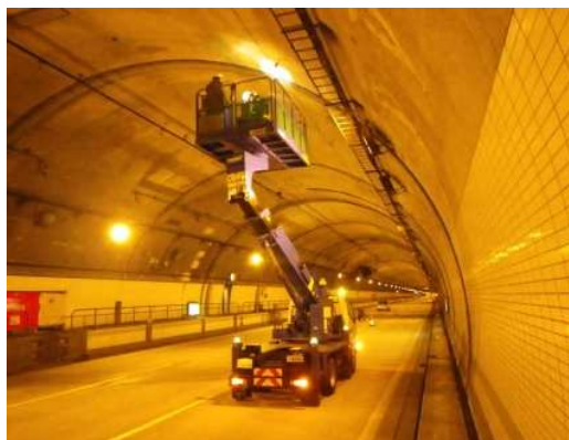
点検状況（土木）
