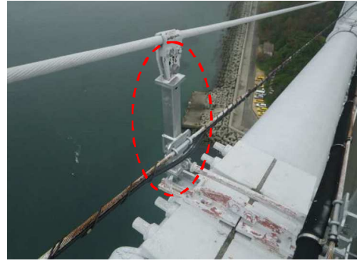
大鳴門橋ハートローブ支柱の取替え
