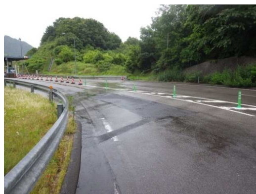
わだち掘れ（補修後）
