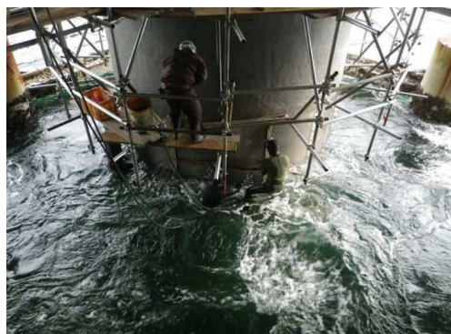
3P 干満部チタンカバー設置状況 (一般国道 28 号 大鳴門橋)
