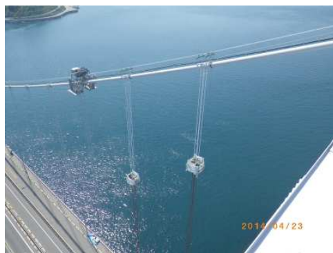
吊橋ハンガーロープの塗替塗装状況 (一般国道 317 号 大島大橋)
