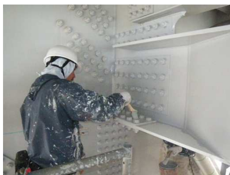
塗替塗装状況 一般国道 30 号 瀬戸大橋
