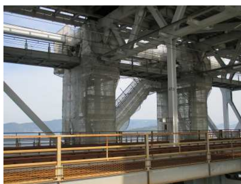
補剛桁の塗替塗装足場 (一般国道 30 号 瀬戸大橋)
