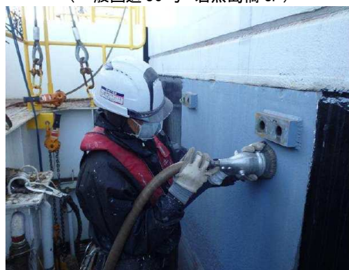
鋼ケーソンの素地調整作業 (一般国道 30 号 岩黒島橋 4P)
