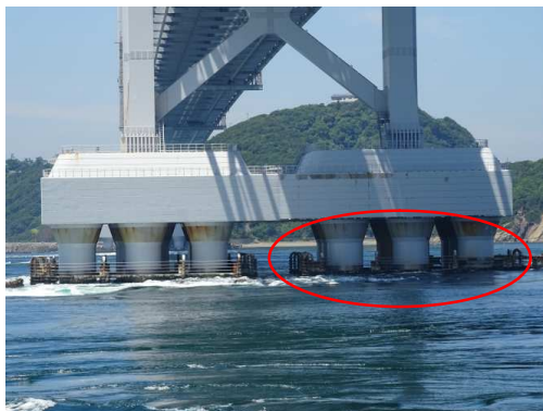
大鳴門橋多柱基礎防食一部完了
