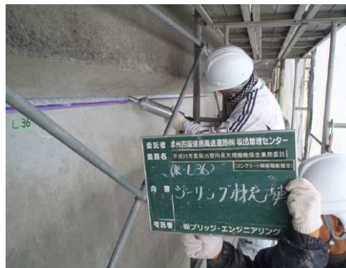
アンカレイジの漏水対策(シーリング補修) (一般国道 30 号 南北備讃瀬戸大橋 4A)
