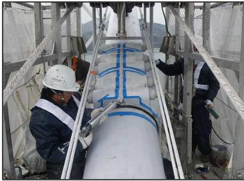
因島大橋ケーブルバンド補修状況
