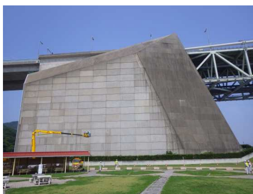
点検状況（長大橋）
