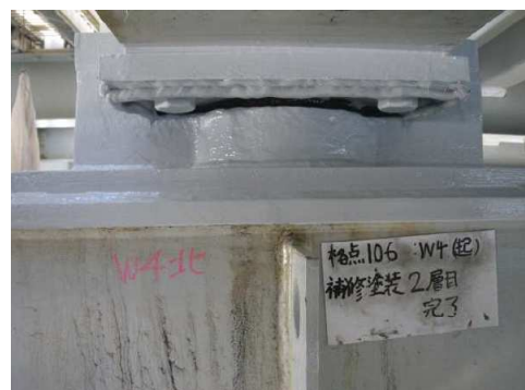
鋼床版縦桁支承の補修 (一般国道 317 号 因島大橋)
