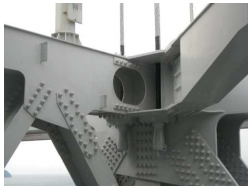
大鳴門橋ハンガーロープ定着部の補修
