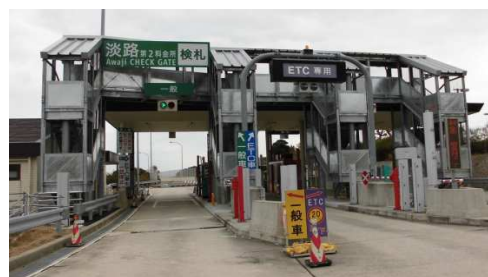
淡路第二料金所の安全通路設置状況
