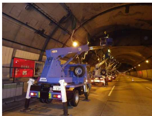
点検状況（機械設備）
