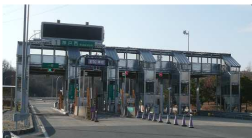
神戸西料金所の安全通路設置状況
