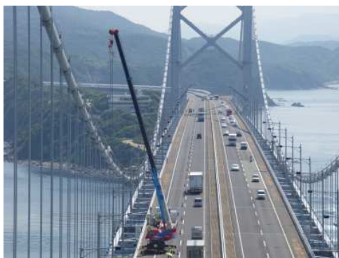
吊橋ハンガーロープの架け替え状況 (一般国道 28 号 大鳴門橋)
