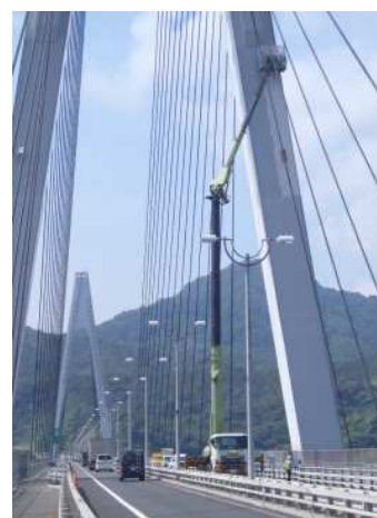
塗替塗装状況 一般国道 317 号 生口橋
