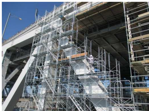
瀬戸大橋塗替塗装足場架設状況
