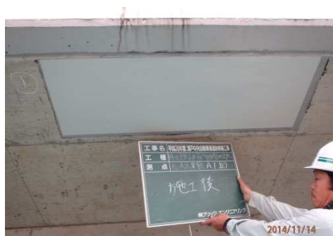
有城高架橋 補修後
