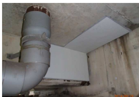
粒江高架橋 補修後
