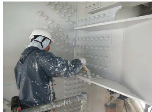
瀬戸大橋塗替塗装実施状況
