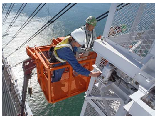
点検状況（機械設備）
