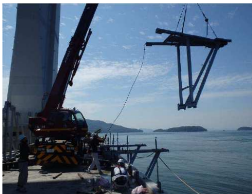
電着工法による防食(設備撤去状況) (一般国道 30 号 岩黒島橋 3P)
