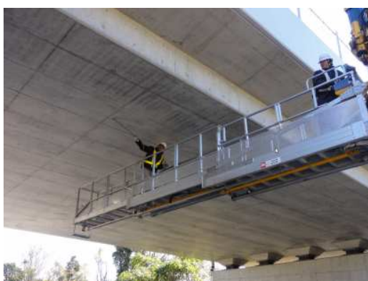
点検状況（土木）
