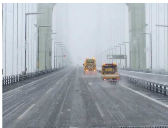
凍結防止剤散布状況
