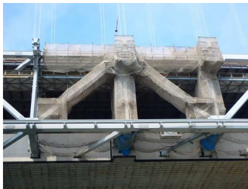
長大橋塗替塗装(瀬戸大橋)
