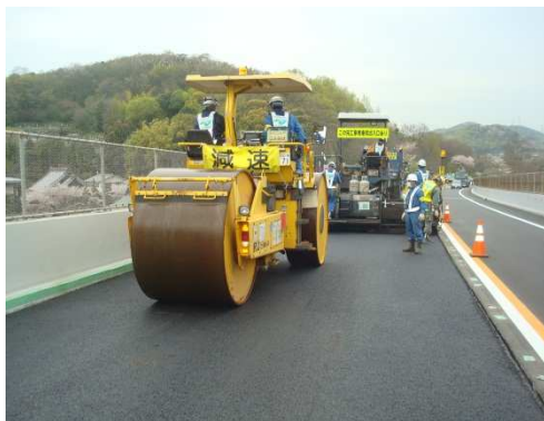
舗装補修(西瀬戸自動車道)
