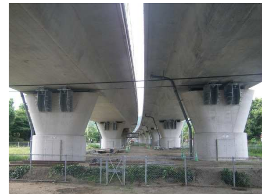
耐震補強(撫養高架橋)
