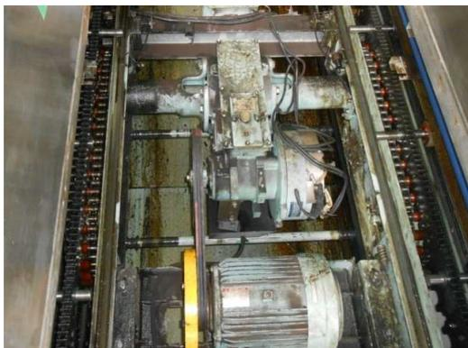
エスカレーター設備用駆動装置（補修前）
