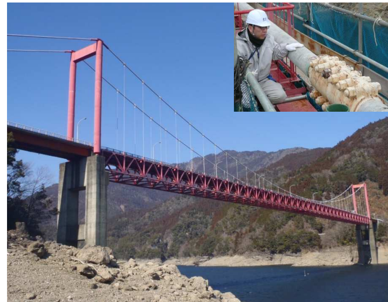
上吉野川橋(高知県)点検補修技術等支援業務
