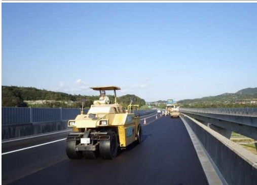
舗装補修(神戸淡路鳴門自動車道)
