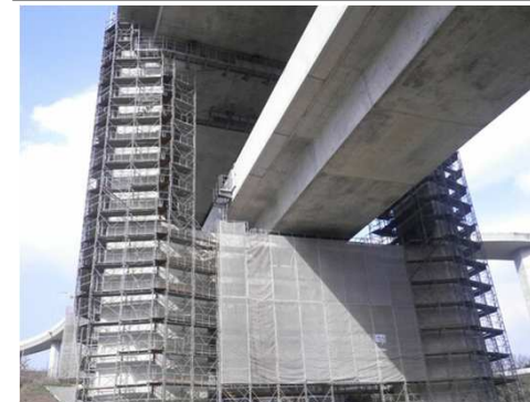
耐震補強(櫃石島高架橋)
