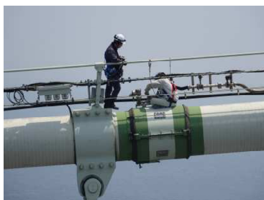
点検状況（長大橋）
