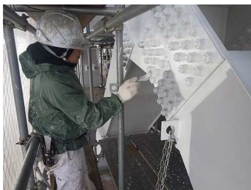
塗替塗装状況 一般国道 30 号 瀬戸大橋
