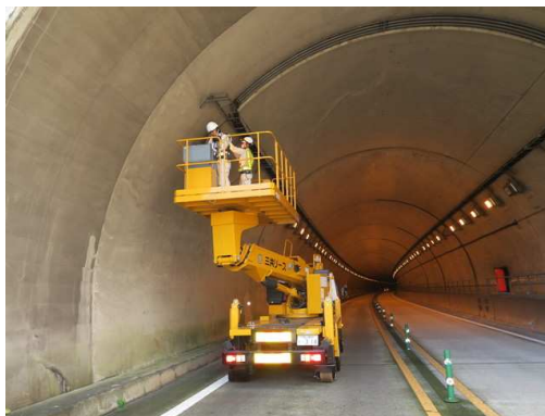
緊急点検実施状況
