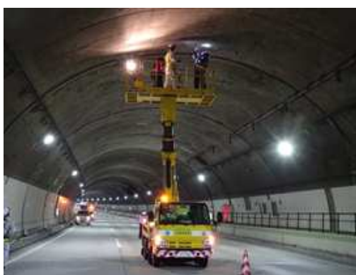
点検状況(土木)
