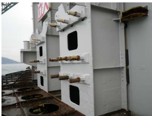
鋼製緩衝工（補修後）
