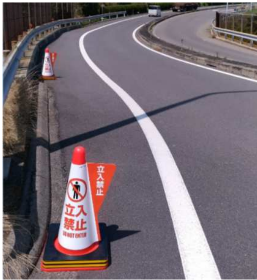
ラバコーンを利用した表示状況 (P A ランプ部設置)
