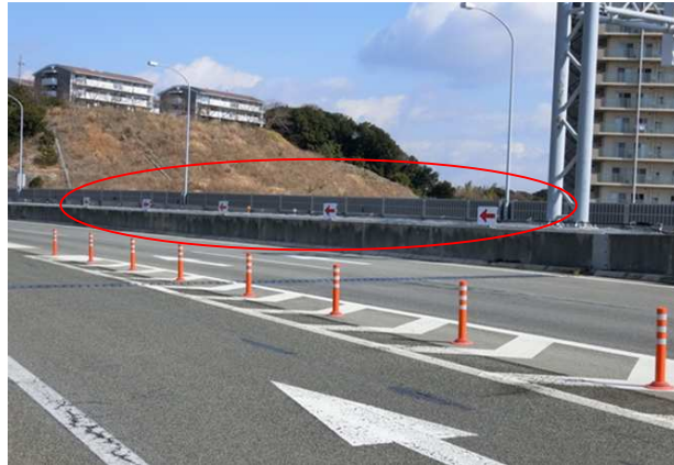
高輝度矢印板の設置
