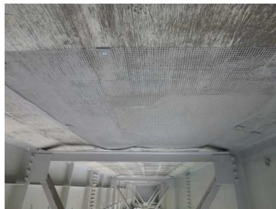
緊急対応（剥落対策）
