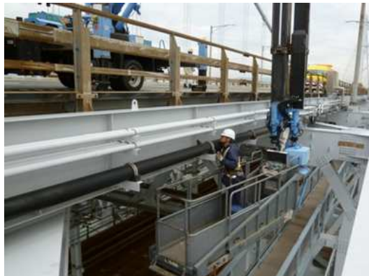
点検状況（機械設備）
