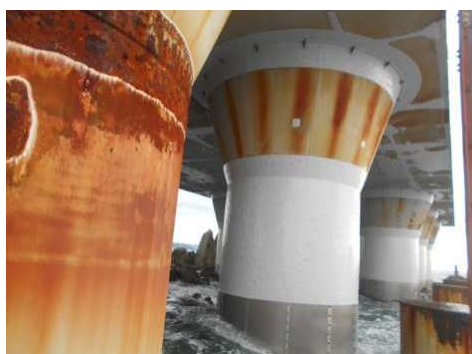
2P 飛沫部塗装、干満部チタンカバー設置状況 (一般国道 28 号 大鳴門橋)
