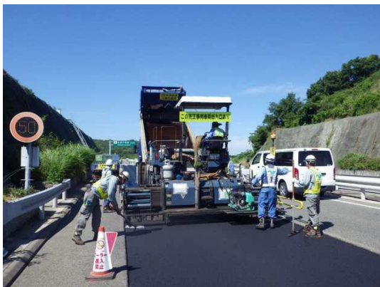
舗装補修工事
