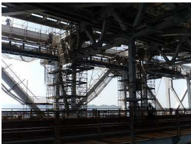
補剛桁の塗替塗装足場 (一般国道 30 号 瀬戸大橋)
