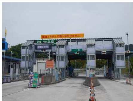
大島南料金所の安全通路設置状況
