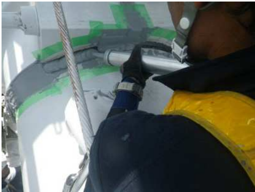
北備讃瀬戸大橋 ケーブルバンドシール補修
