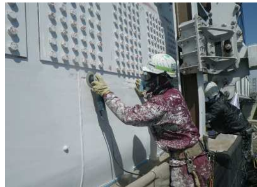
瀬戸大橋塗替塗装実施状況
