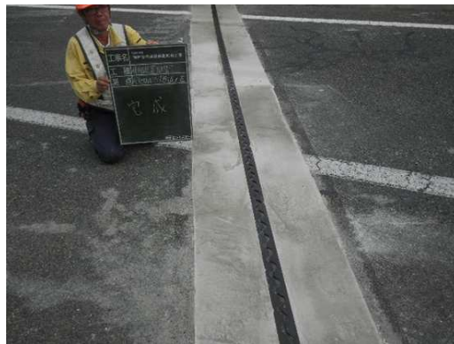
伸縮装置（補修後）
