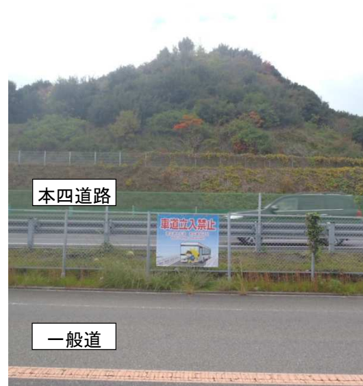
立入発生箇所への表示状況 (立入防止柵設置)
