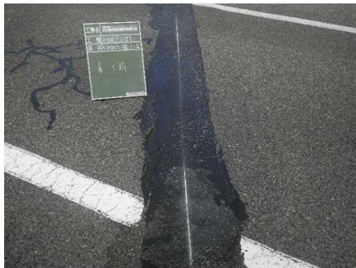
伸縮装置（補修前）
