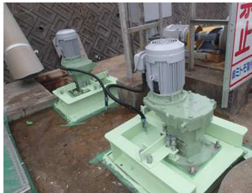
凍結防止設備用攪拌機（補修後）
