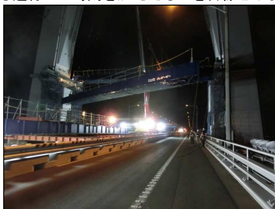
通行止めを伴う工事の作業状況
