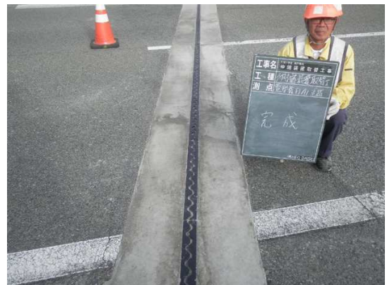
伸縮装置補修工事
