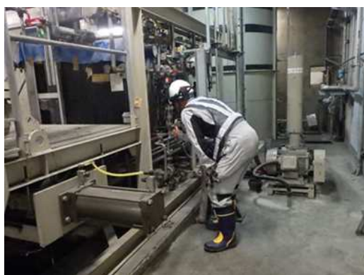
点検状況（機械設備）
