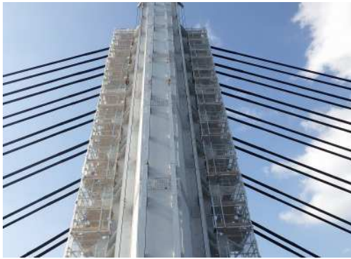
瀬戸大橋塗替塗装足場架設状況
