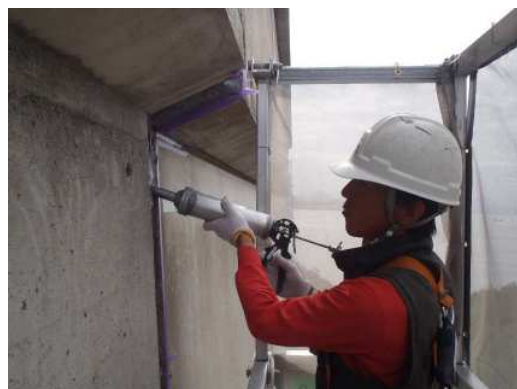
アンカレイジの漏水対策(シール補修) (一般国道30号 南北備讃瀬戸大橋1A)
