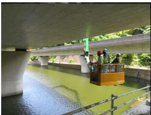
点検状況（土木）
