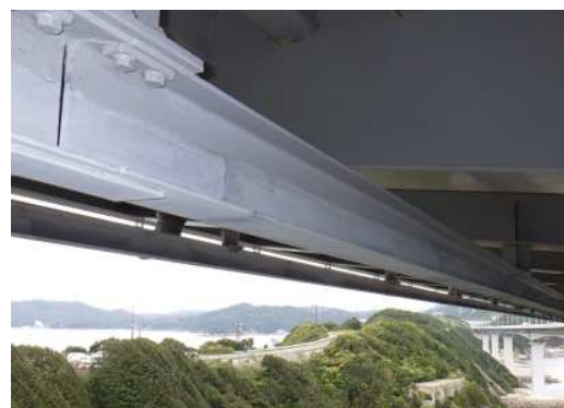
門崎高架橋作業車レール金属溶射完了
