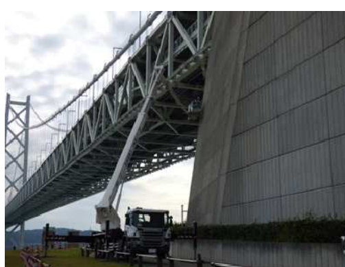
点検状況（長大橋）
