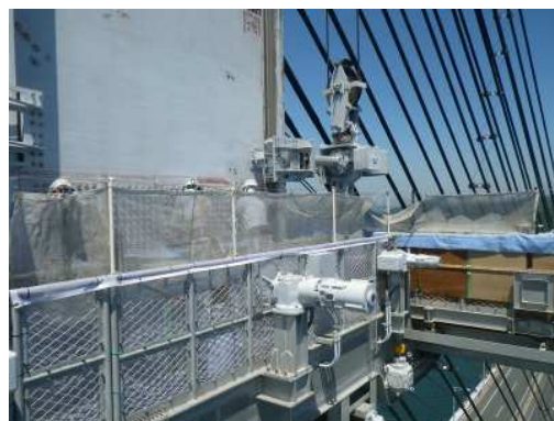
塗替塗装状況 一般国道 30 号 瀬戸大橋
