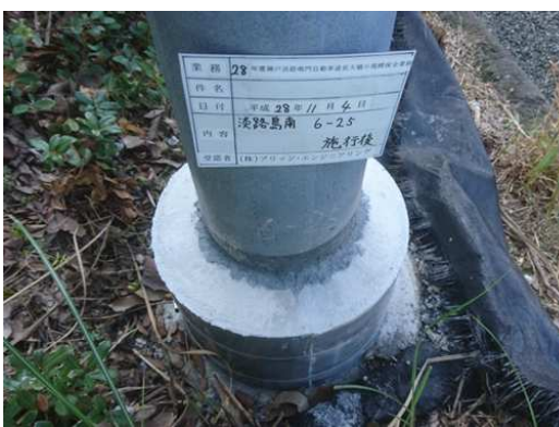
照明柱基部（補修後）
