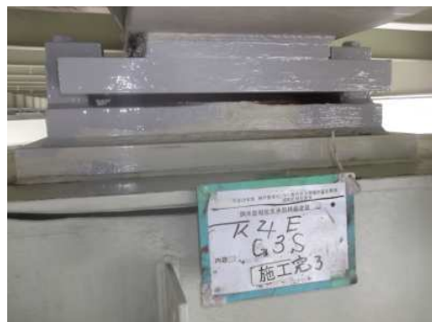
鋼床版縦桁支承の補修 (一般国道 28 号 明石海峡大橋)
