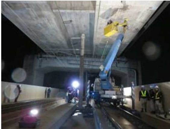
ＪＲ軌道上高架橋の打音点検
