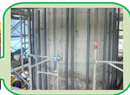
コンクリート橋脚の補強(垂水 IC I ランプ橋)
