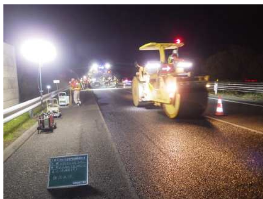
緊急対応（舗装補修）
