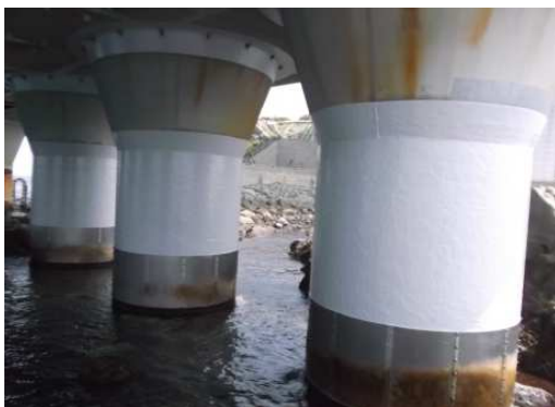
大鳴門橋多柱基礎防食一部完了
